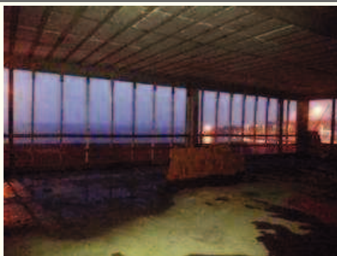
- Execução do guarda corpo do 3º pavimento.
