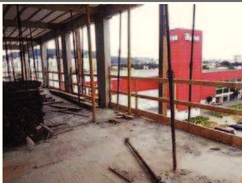
- Execução de guarda corpo na periferia do 4º pavimento.
