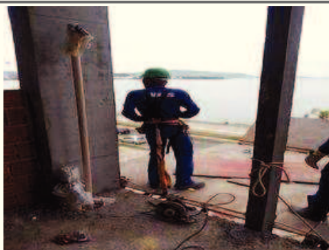
- Manutenção da plataforma de segurança secundaria.
