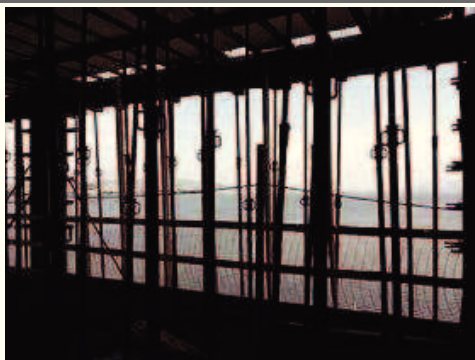
- Execução do guarda corpo da laje tipo 1.
