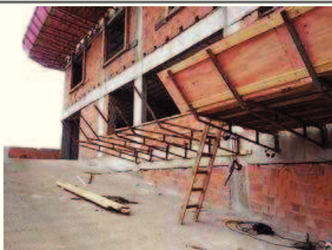
Execução da Plataforma de segurança primaria. 07/07/2015 - Guarda Corpo Laje Tipo 1
