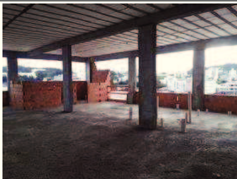
- Execução de guarda corpo na periferia do 3º pavimento;
