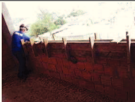
Execução da alvenaria de bloco celular na escada do pavimento terreo.
