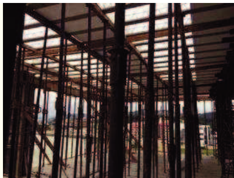
Execução da montagem da laje do Pavimento Tipo 2.
