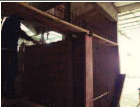
Execução Forma contraverga Pavimento Terreo.
