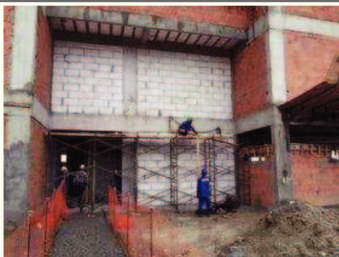
- Montagem da Plataforma de segurança primaria. 08/07/2015 - Guarda Corpo Elevador
