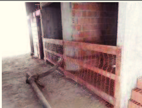
- Fechamento do vãos dos elevadores.
