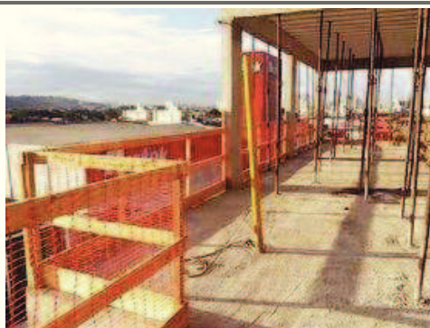
- Execução de guarda corpo na periferia da Laje Tipo 1.
