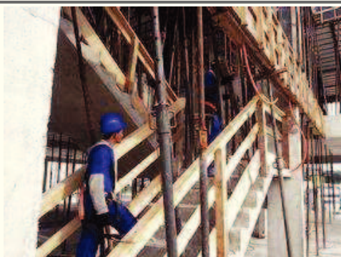
- Execução de guarda corpo nas escadas;
