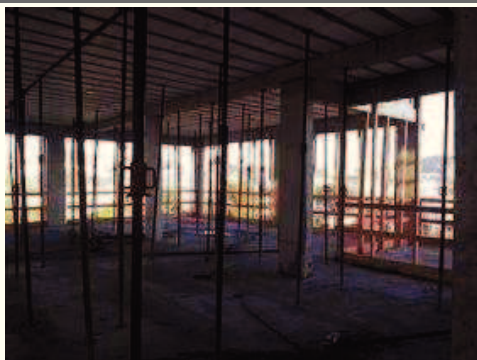
- Execução do Guarda Corpo na laje tipo 1.
