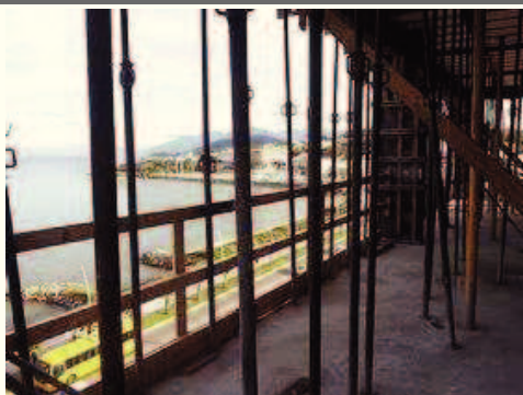
- Execução de guarda corpo na periferia da Laje Tipo 2.
