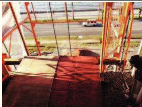
- Substituição das rampas do elevador; 20/07/2015 - Linha de Vida
