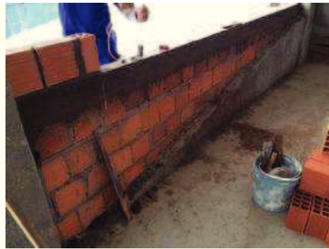
Execução da alvenaria do pavimento térreo
