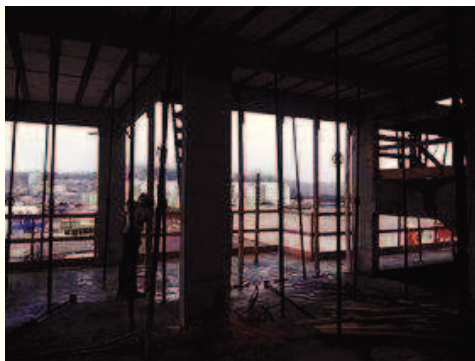
- Execução do guarda corpo da laje tipo 1; 07/07/2015 - Plataforma de Segurança
