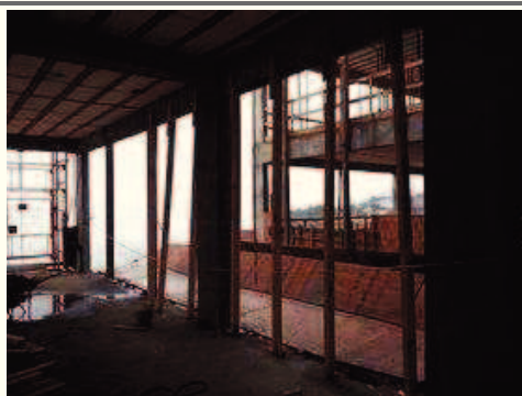
- Execução do guarda corpo do 3º pavimento; 07/07/2015 - Guarda Corpo Escada
