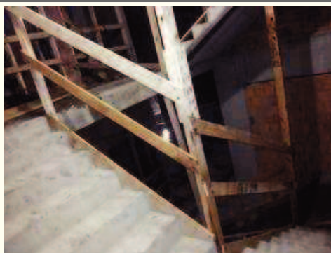
- Execução do guarda corpo das escadas; 08/07/2015 - Guarda Corpo Laje Tipo 1
