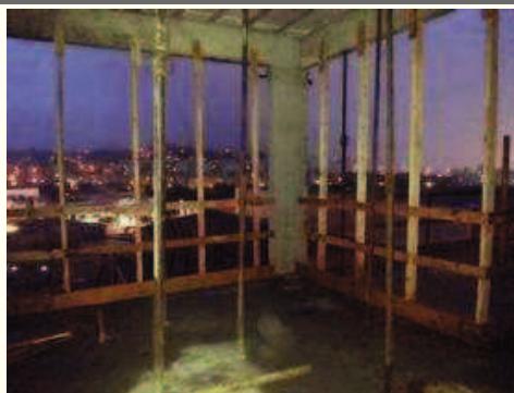
- Execução do guarda corpo das escadas; 08/07/2015 - Guarda Corpo Laje Tipo 1
