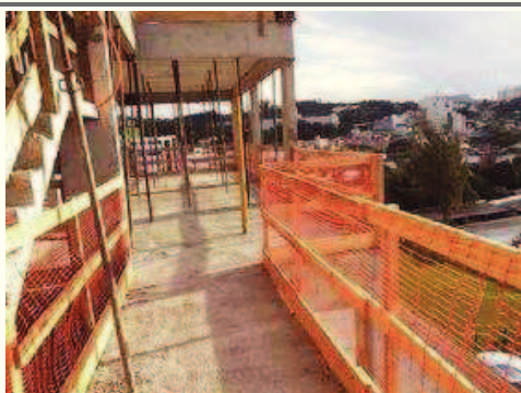
- Execução da plataforma de segurança secundaria; 03/07/2015 - Guarda Corpo Laje Tipo 2
