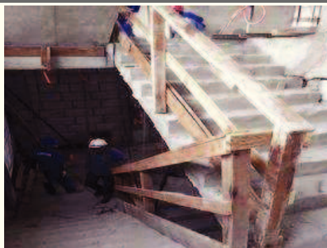
- Execução de guarda corpo nas escadas.
