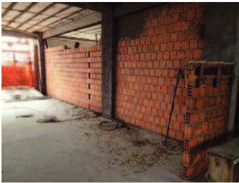
Execução da alvenaria do pavimento térreo
