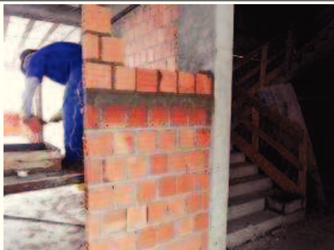
Execução da alvenaria no pavimento terreo.
