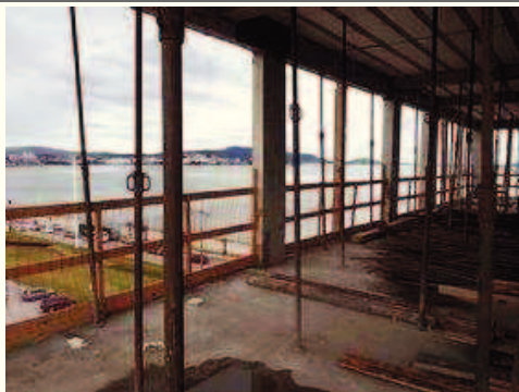
- Execução do guarda corpo no 3º Pavimento.
