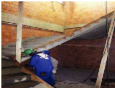
- Execução do guarda corpo das escadas; 08/07/2015 - Guarda Corpo Escada
