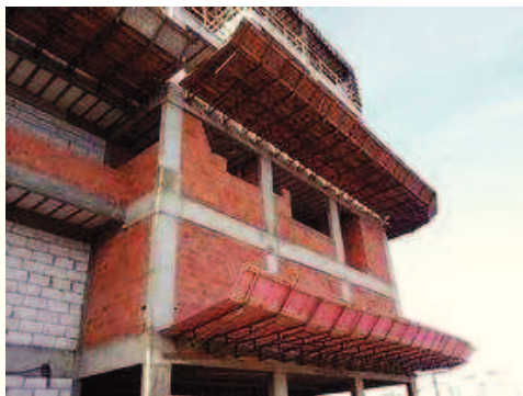
- Manutenção da plataforma de segurança primaria e secundaria.
