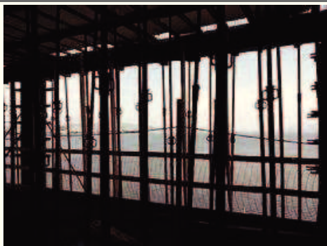
14/07/2015 - Guarda Corpo Laje Tipo 1
