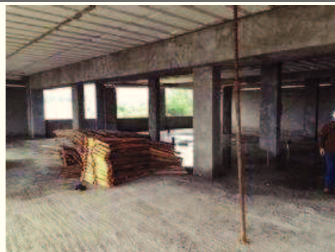
Execução Chapisco do 1º Pavimento.
