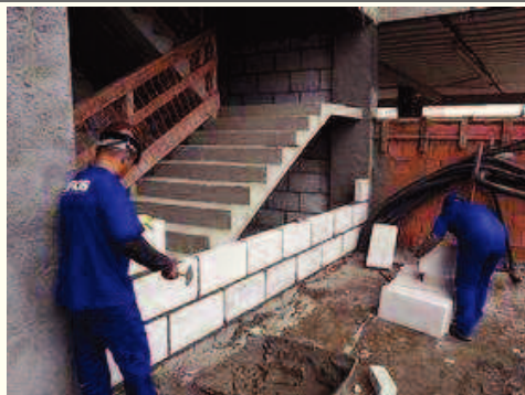
Execução da alvenaria de bloco celular na escada do pavimento terreo.
