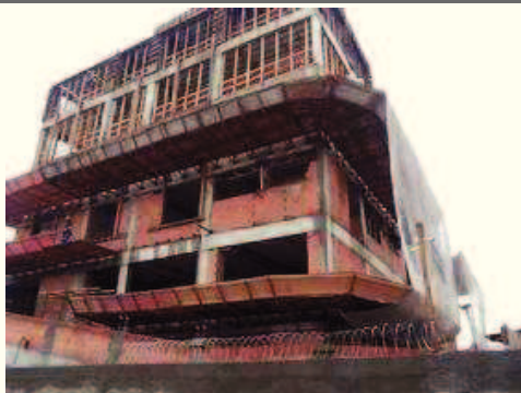
- Montagem da plataforma primária. 17/07/2015 - Desmonte Policorte
