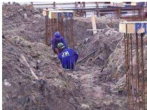
Montagem dos blocos-2
