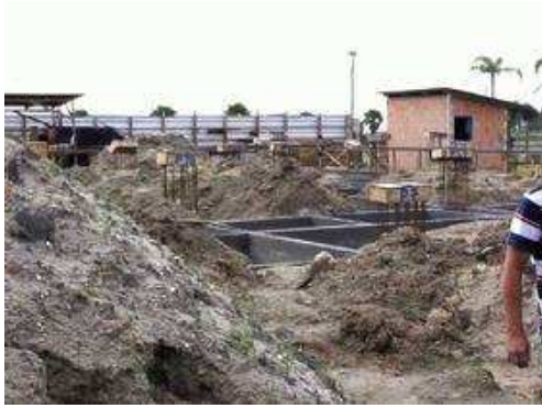
Desforma vigas baldrame 2.
