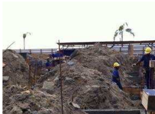
Desforma vigas baldrame 1.
