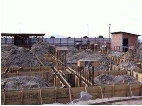
Colocação das formas e ferragem das vigas baldrame 2.
