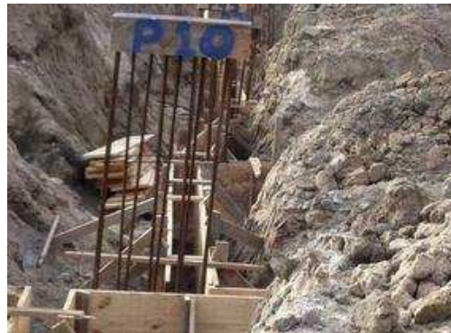
Concretagem das vigas baldrame 1.
