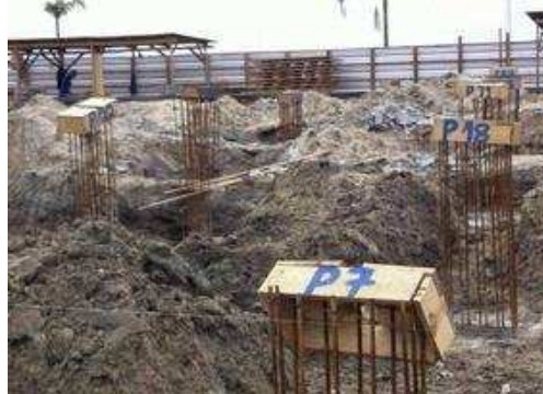
Montagem dos blocos-1
