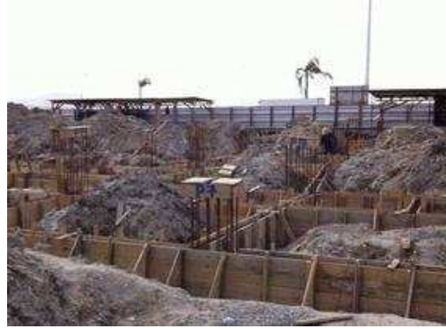
Colocação das formas e ferragem das vigas baldrame 3.
