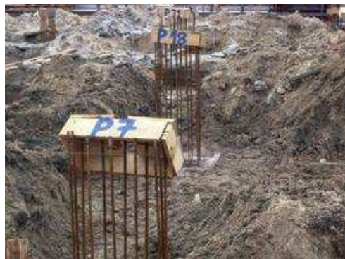
Montagem dos blocos-3
