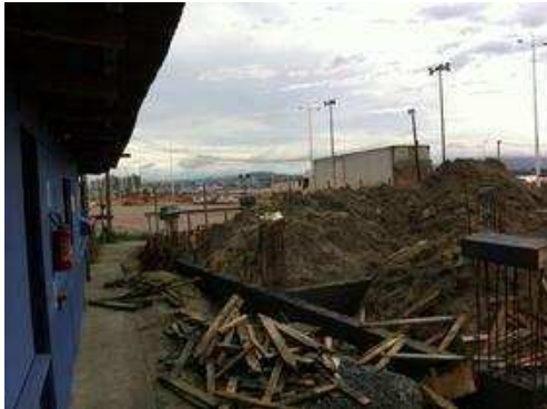
Desforma vigas baldrame 4.
