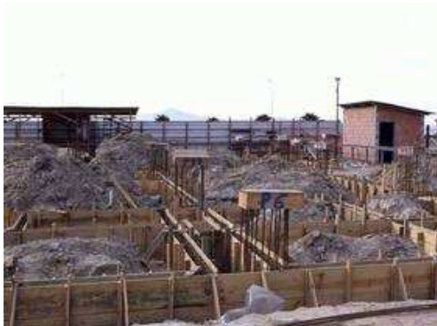
Concretagem das vigas baldrame 2.
