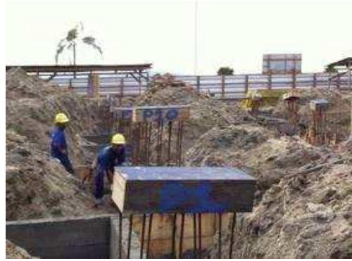
Desforma vigas baldrame 3.
