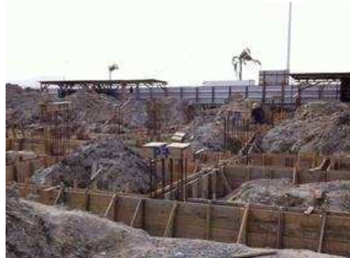
Concretagem das vigas baldrame 3.
