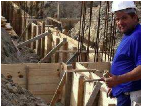
Colocação das formas e ferragem das vigas baldrame 4.
