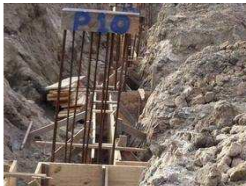
Colocação das formas e ferragem das vigas baldrame 1.
