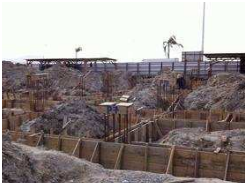
Concretagem das vigas baldrame 4.
