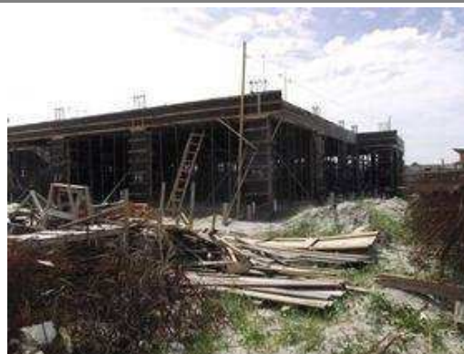
Estrutura pavimento nível térreo 2.
