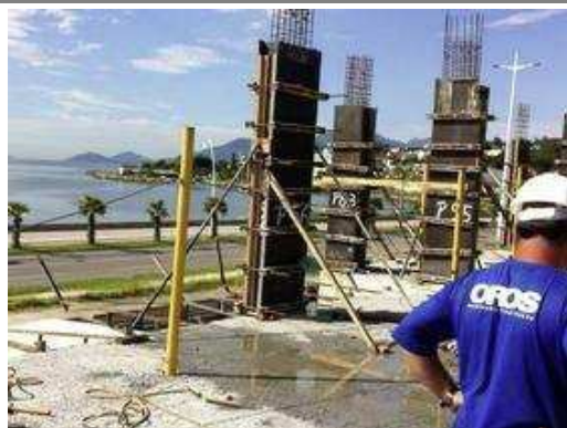
Pilares 1º pavimento - 2
