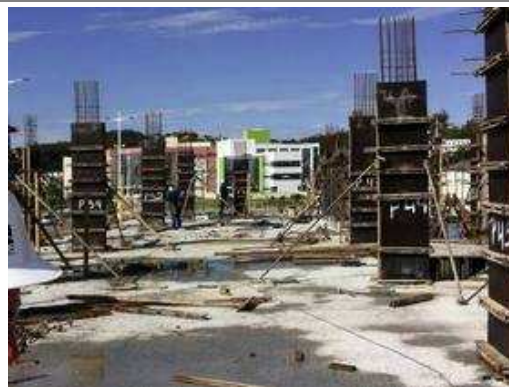
Pilares 1º pavimento - 1
