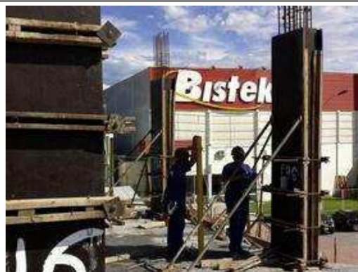
Pilares 1º pavimento - 3
