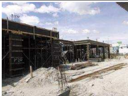
Estrutura pavimento nível térreo 1.
