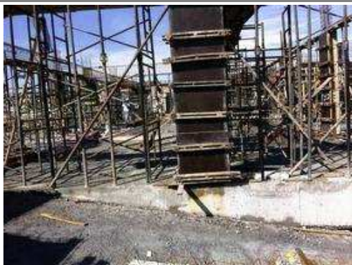
Estrutura 1º pavimento - 4
