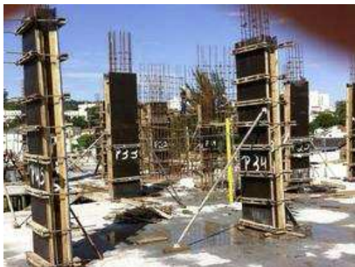
Pilares 1º pavimento - 4
