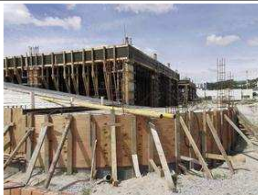
Estrutura pavimento nível térreo 3
