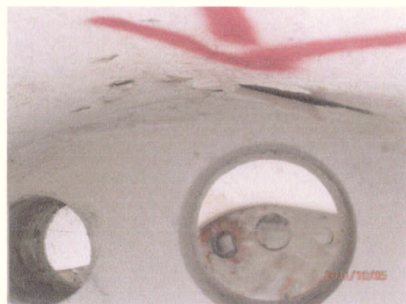
Foto 12 Furação nas Lajes p/ passagem dutos
