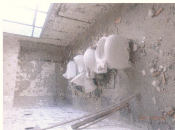
Foto 10 Retirada de Azulejos e Louças
