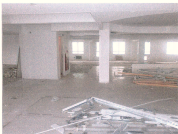
Foto 05 Retirada de Eletro Calhas
