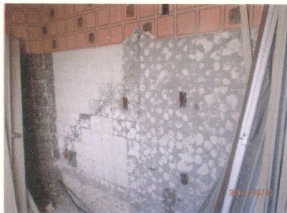
Foto 08 Retirada de Azulejos
