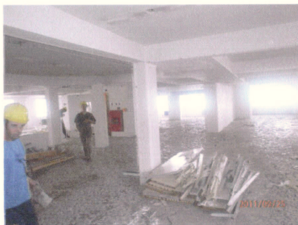
Foto 06 Retirada de Piso Paviflex
