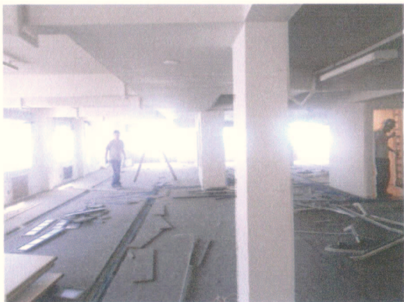
Foto 01 Desativação Energia Elétrica
