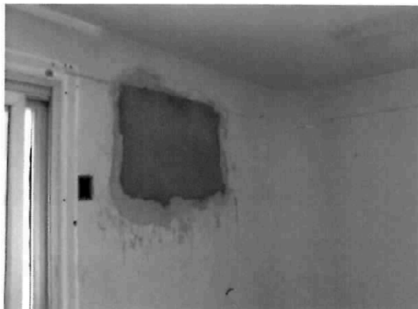
Foto 2 Revestimento aberturas ar condicion.
