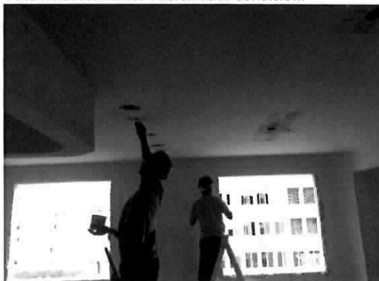
Foto 2 Revestimento aberturas ar condicion.
