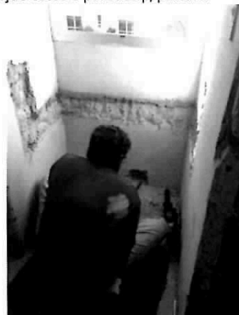
Foto 6 Furos p/colocação bandejas
