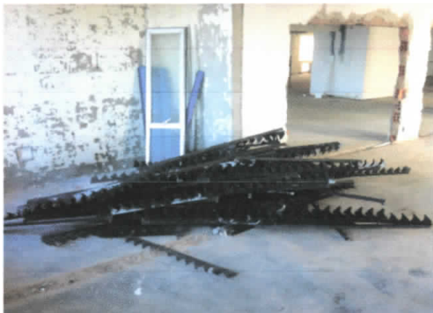
Foto 7 Retirada de brises
