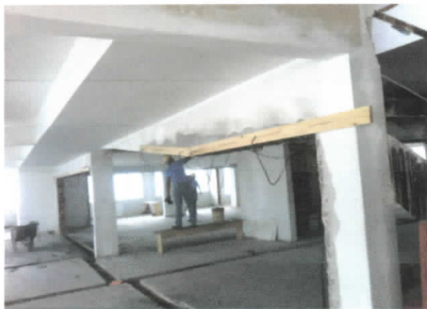
Foto 1 Requadro de paredes e vigas.
