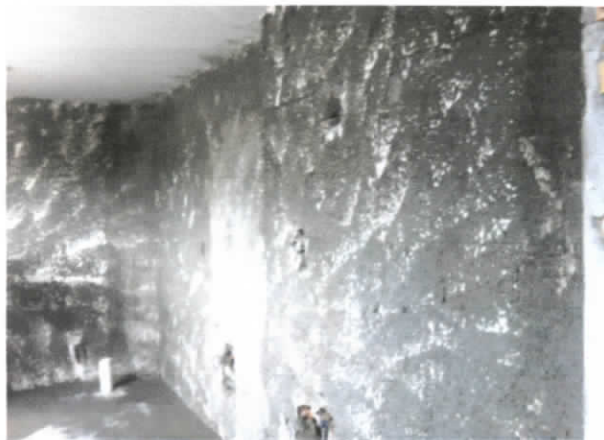
Foto 2 Revestimento paredes - chapisco.
