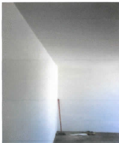
Foto 4 Pintura paredes e tetos
