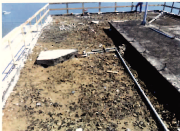
Foto 7 Demolição do contra piso na cobertura
