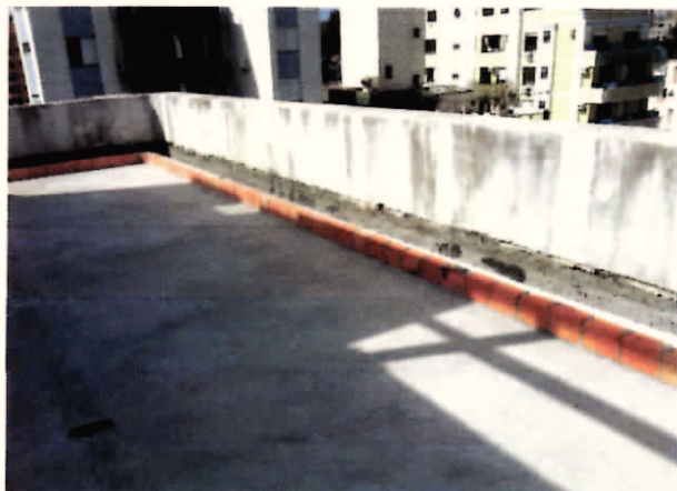
Foto 1 Instalações hidro sanitárias no ático.
