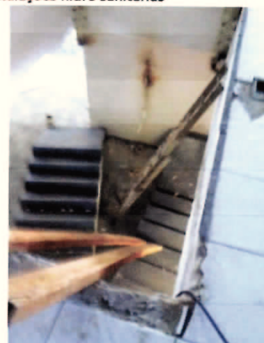
Foto 4 Retirada da escada metálica do térreo
