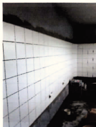
Foto 10 Colocação de azulejos cerâmicos
