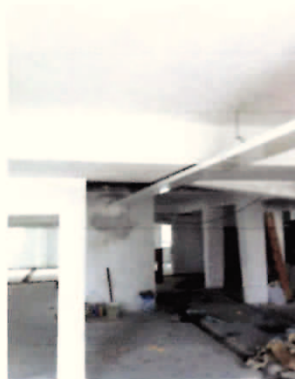
Foto Colocação calhas elétricas
