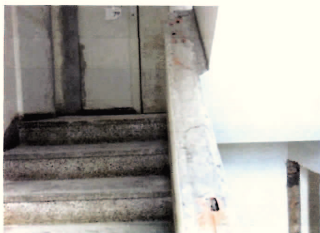
Retirada de soleiras e peitoris da escadaria
