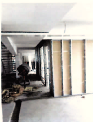
Foto 9 Montagem das divisórias
