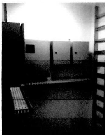
Colocação de quadros elétricos
