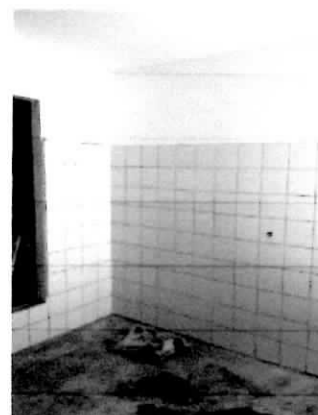
Paredes dry wall com revestimentos e instalação hidráulica
