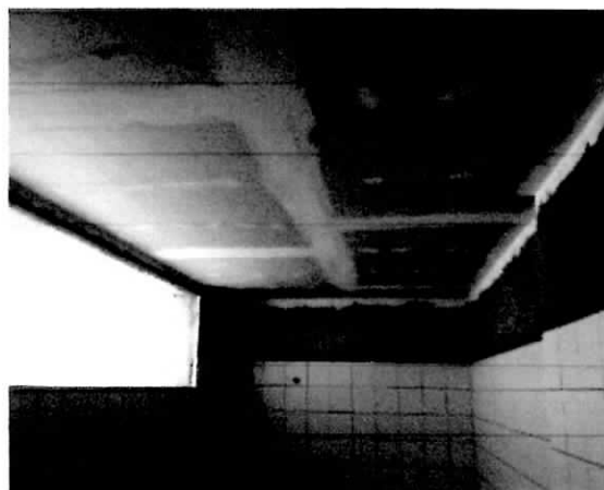
Colocação de forros
