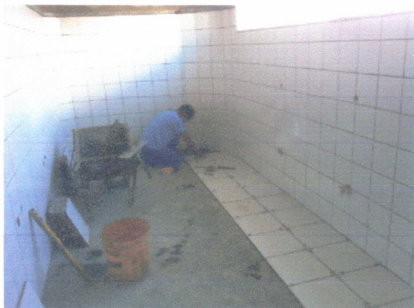
Colocação de piso cerâmico
