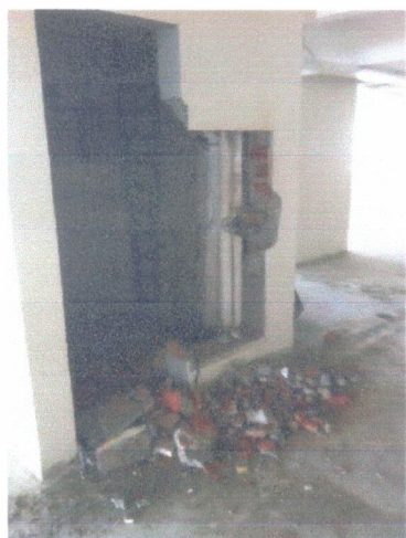
Retirada registros e caixas de incêndio
