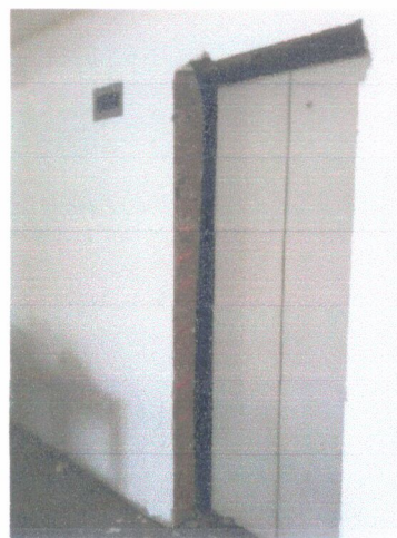
Retirada forras elevadores
