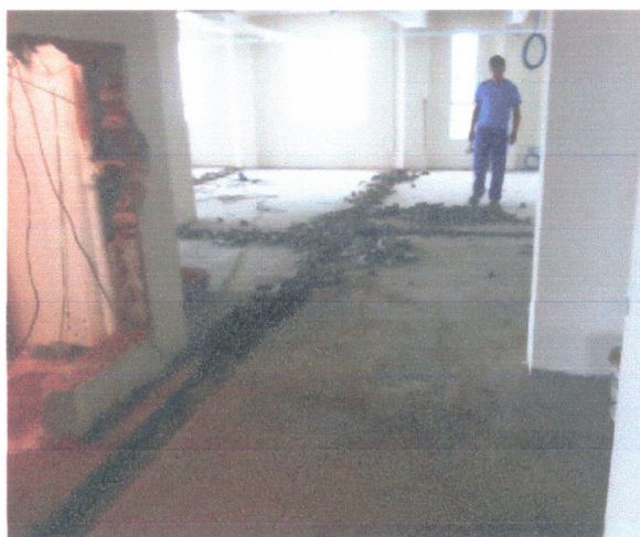
Quebra do piso para tubulação do ar
