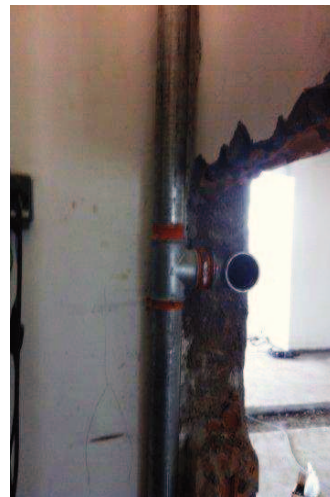
Tubulação da rede de incêndio (aditivo)
