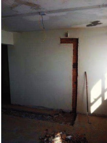
Quebra piso tubulação ar condicionado (aditivo)
