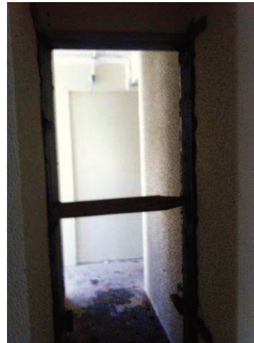
Colocação de contramarco portas corta-fogo
