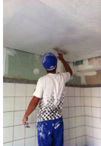
Pintura de paredes e tetos
