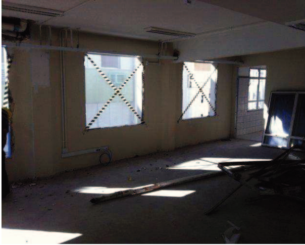
Retirada de esquadrias (aditivo)
