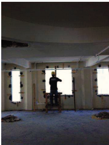
Tubulação do ar condicionado (cfe. aditivo)
