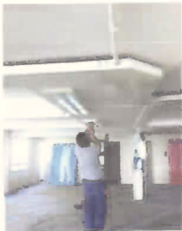
Colocação de luminárias 7º e 8º pvto
