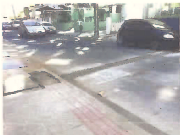
Travessia da rua p/entrada de emergência
