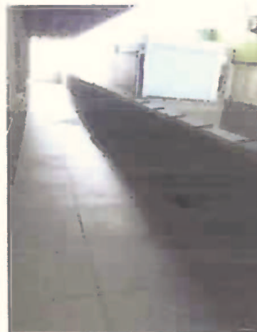
Colocação piso 1º pvto
