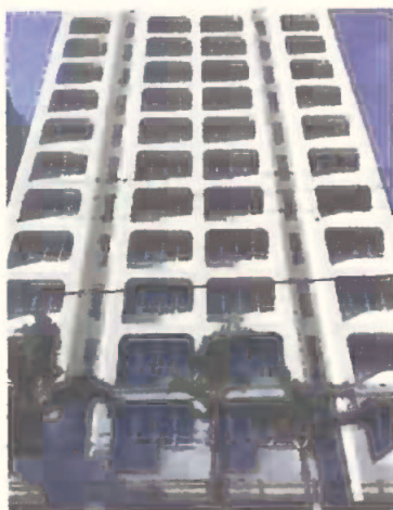
Fachada com todas janelas colocadas
