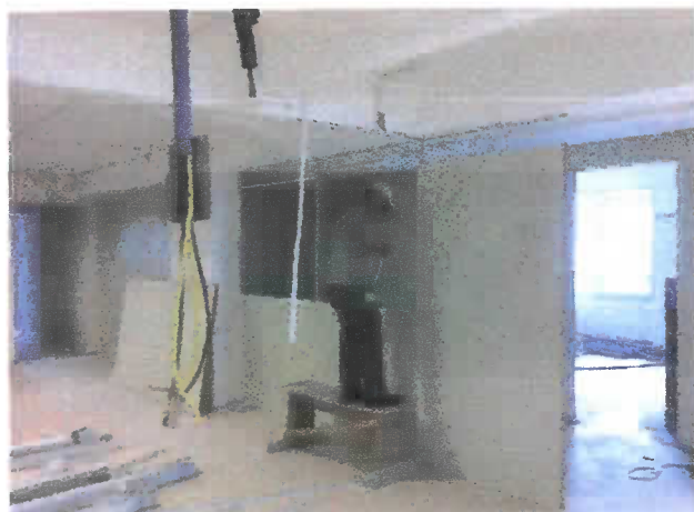
Colocação divisórias 5º pvto
