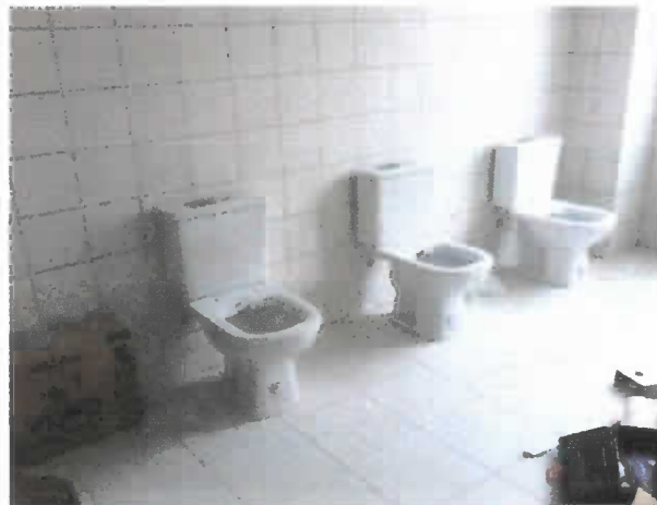
Instalação louças 10º pvto
