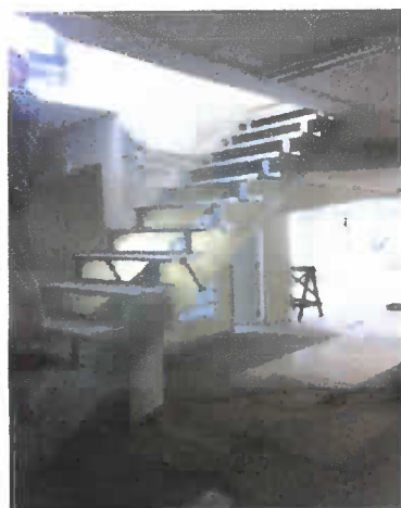
Colocação escada metálica acesso ático
