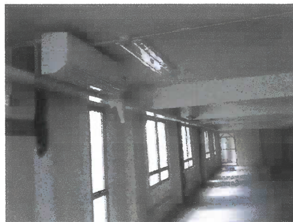
Colocação AC 11º pvto
