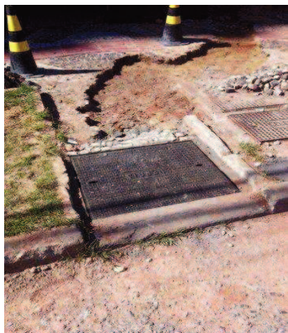
Caixa entrada de energia na Av. Beiramar
