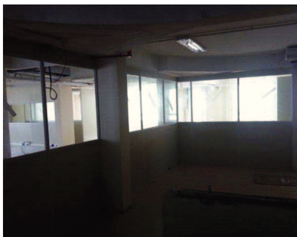
Colocação vidros nas divisórias 10º pvto
