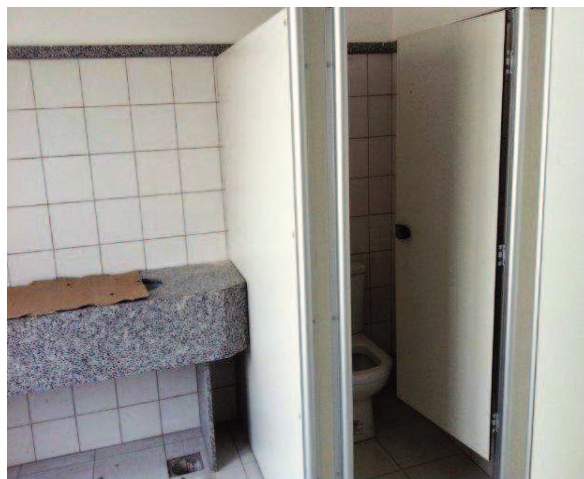
Instalação do sanitário no 7º pvto.
