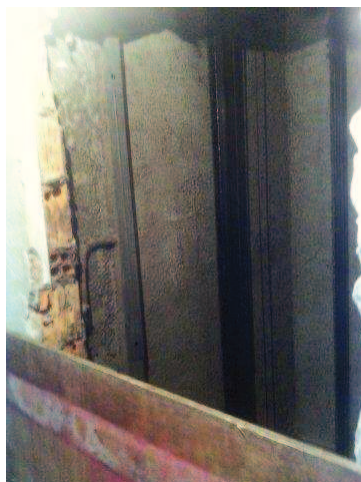
Retirada portas elevador serviço
