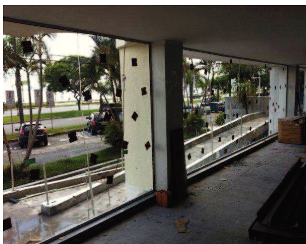
Colocação de vidros térreo
