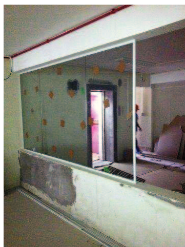
Colocação de vidros painel de comunicação
