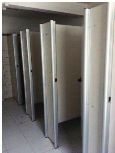
Divisórias nos banheiros 10º pvto
