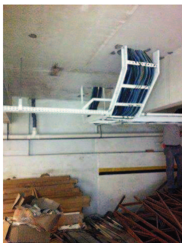
Colocação cabos da subestação
