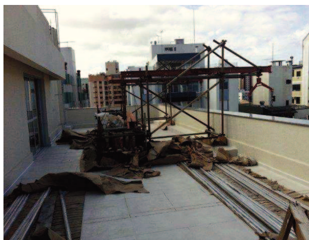
Montagem andaime externo
