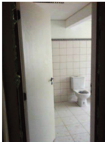
Colocação portas de madeira 8º pvto
