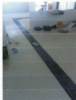
Colocação de piso tátil
