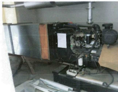
Montagem do gerador
