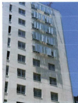
Colocação de brises
