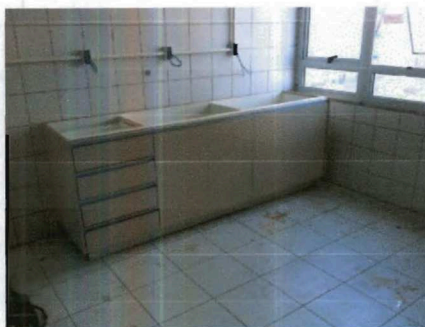
Instalação do mobiliário das copas
