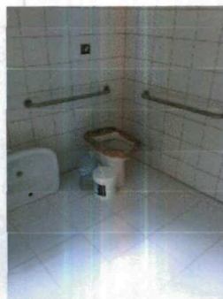
Instalação de louças e metais
