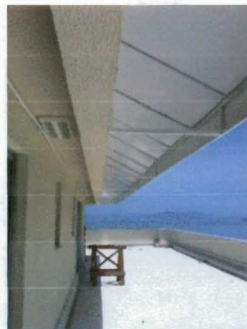
Colocação de toldos no ático
