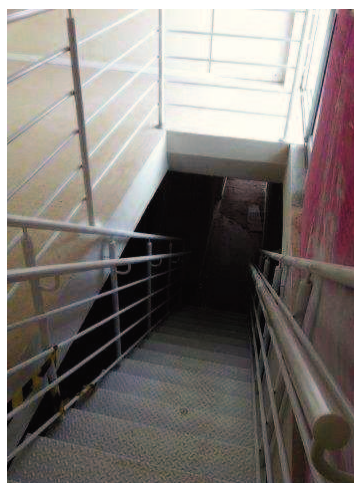
Pintura da escada
