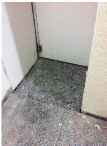
Colocação granito hall elevador serviço
