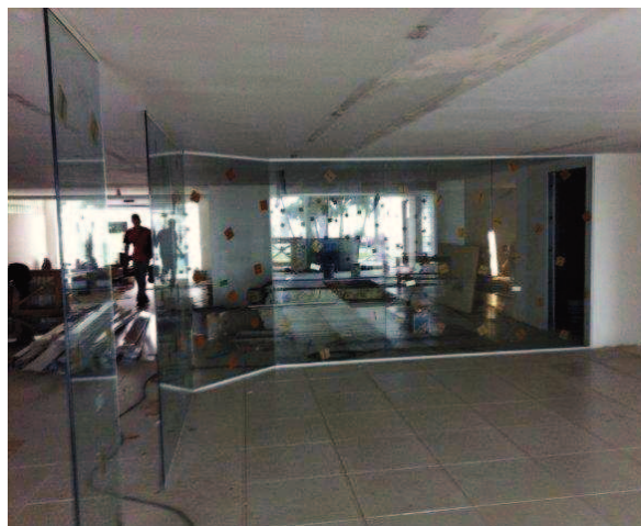
Colocação divisória de vidro térreo
