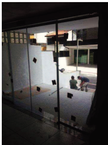
Colocação porta de vidro térreo
