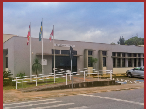
Fachada da sede da Vara do Trabalho de Indaial.
