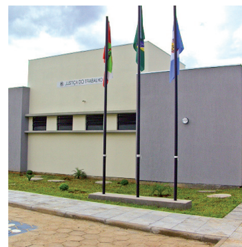
Fachada da sede da Vara do Trabalho de Videira.
