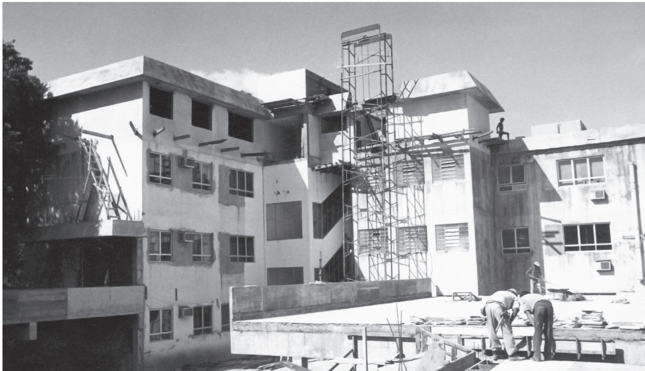
Obras de reforma e ampliação do prédio-sede, na rua Prof. Luiz Sanches Bezerra da Trindade, em 1983.
