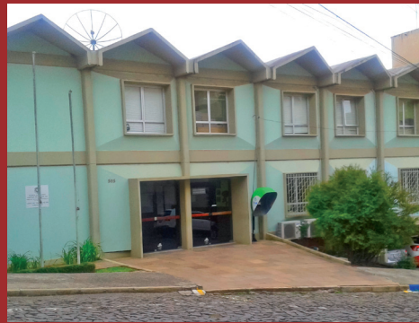
Fachada da sede da Vara do Trabalho de Caçador.
