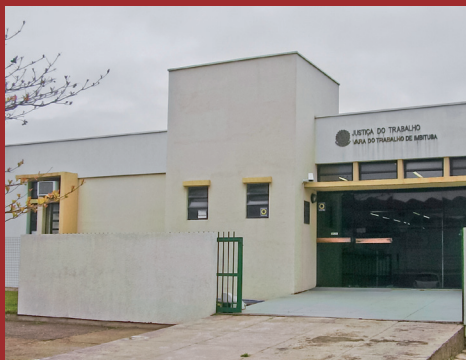
Fachada da sede da Vara do Trabalho de Imbituba.
