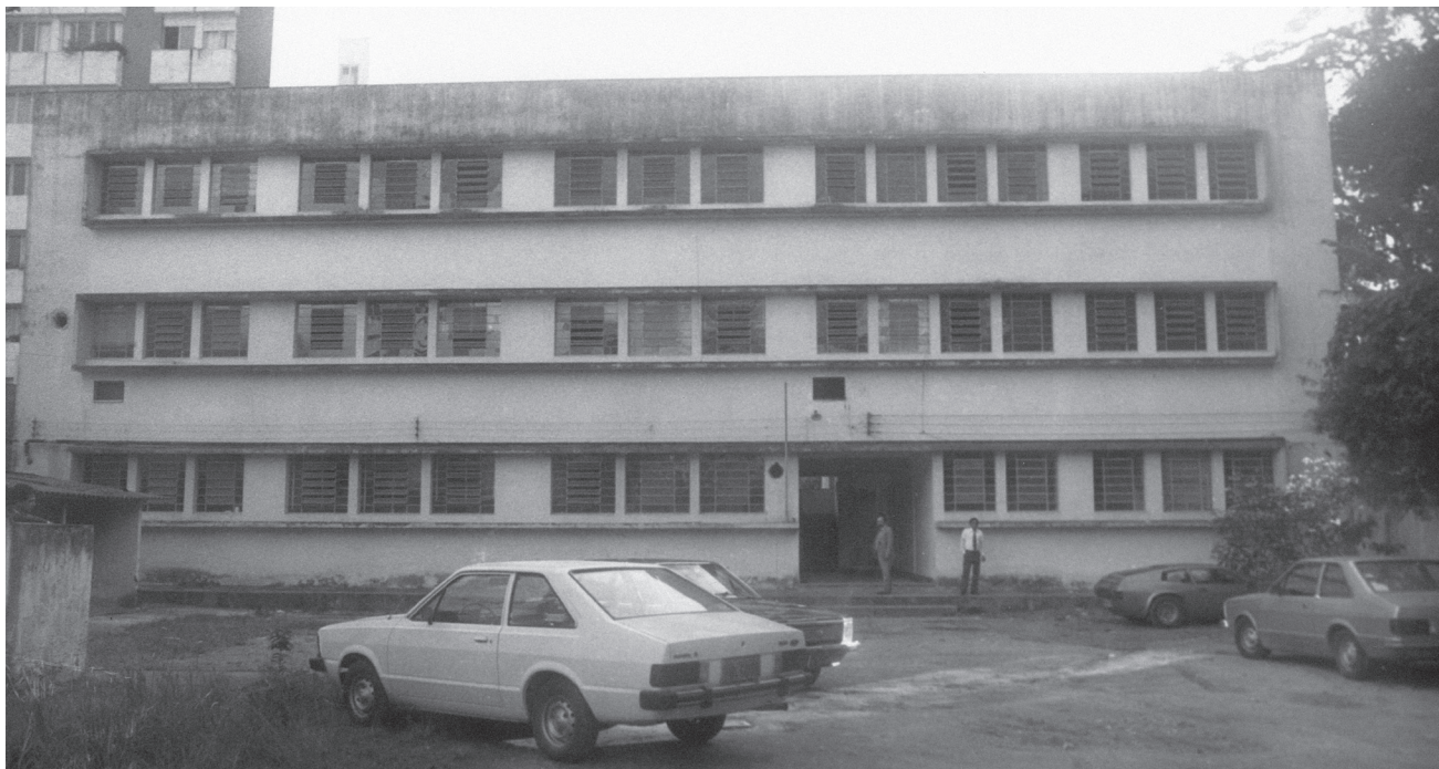
Primeira sede própria do TRT da 12ª Região, na rua Esteves Júnior, em 1982. O imóvel pertencia à Universidade Federal de Santa Catarina e foi adquirido pelo TRT em 1981. A esse imóvel, posteriormente, foi anexada outra área de 660 m 2 , sem edificações, com frente para a rua Prof. Luiz Sanches Bezerra da Trindade, formando, assim, uma área de 3.434 m 2 , com frente para ambas as vias públicas.
