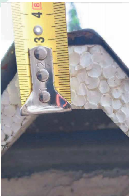
Foto 01: Telha Trapezoidal TP40 (3cm) (E); Foto 02: Laje de cobertura (9cm) (D).
