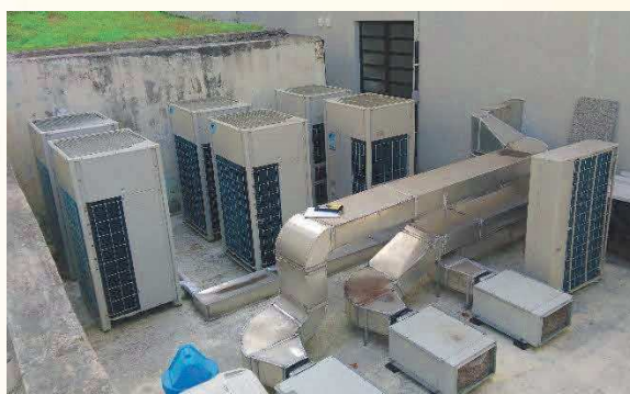
Foto 23: Condensadoras do Sistema VRF instaladas (E); Foto 24: Isolamento térmico das unidades VRF (D).
