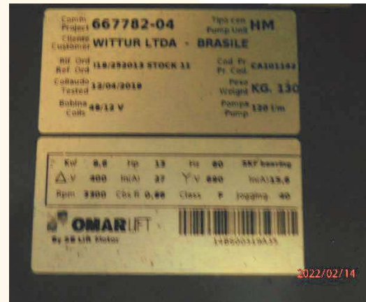
Foto 27 e Foto 28: Placa de Identificação do Elevador Dinâmica ELHP-600-30.
