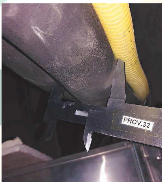
Foto 25: Isolamento térmico das unidades VRF (E); Foto 26: Controle individual das evaporadoras do VRF (D).
