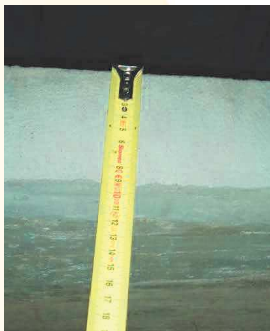
Foto 01: Telha Trapezoidal TP40 (3cm) (E); Foto 02: Laje de cobertura (9cm) (D).
