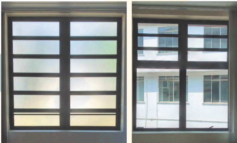
Foto 07: Abertura 2O A01-J02 (E); Foto 08: Abertura 2S A04-J04 (D).
