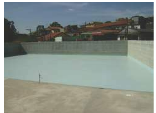
Aplicação do Hidroplast sobre o primer
