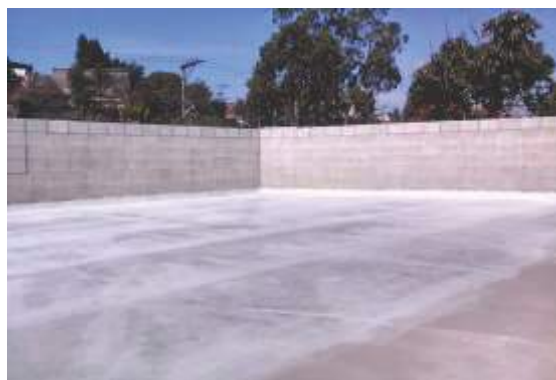
Aplicação do primer simultaneamente com a tela
