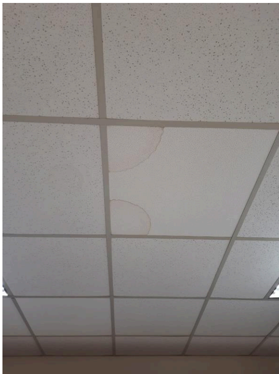
Fotografia 58 – Manchas de umidade no forro interno
