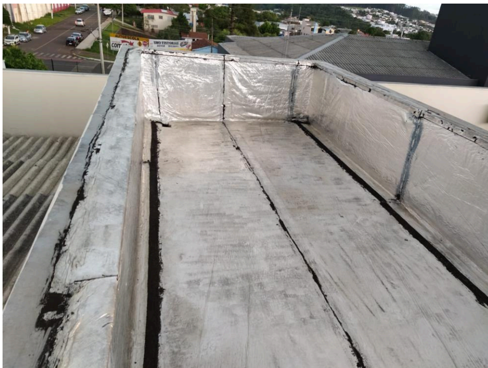
Fotografia 37 – Sistema de impermeabilização existente da claraboia 01
