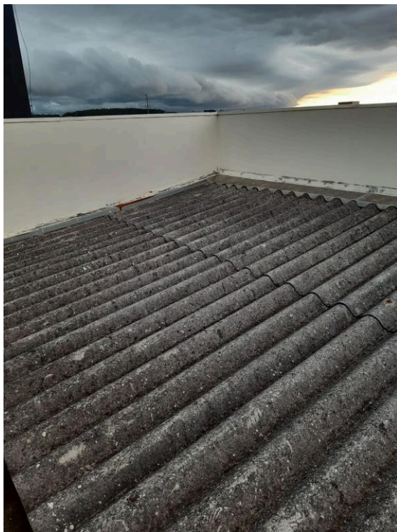
Fotografia 06 – Telhas de fibrocimento da cobertura com deterioração
