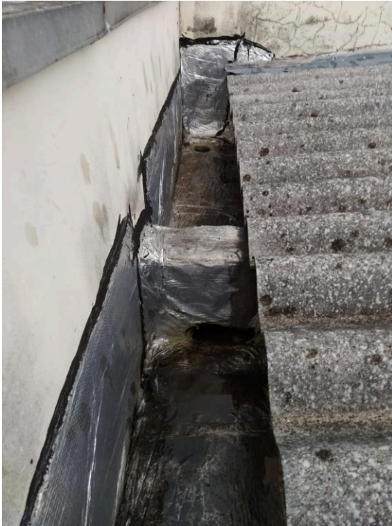
Fotografia 29 – Calha do torre 01 com acúmulo de água e impermeabilização comprometida
