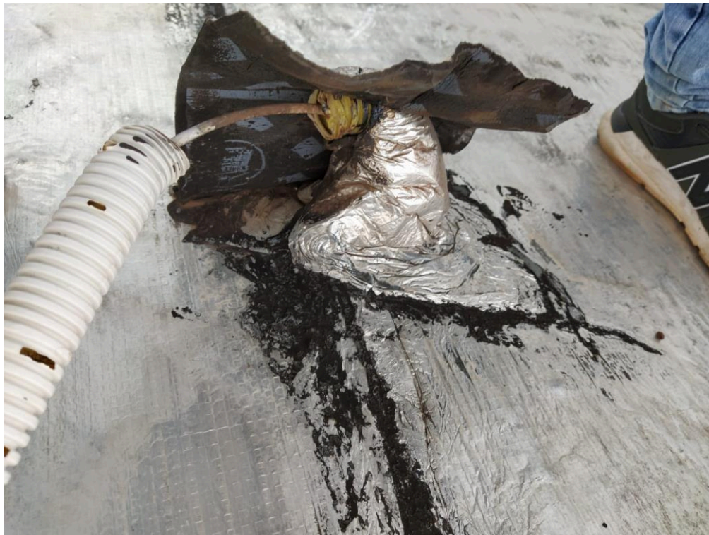
Fotografia 42 –Passagem elétrica no sistema de impermeabilização da claraboia 02
