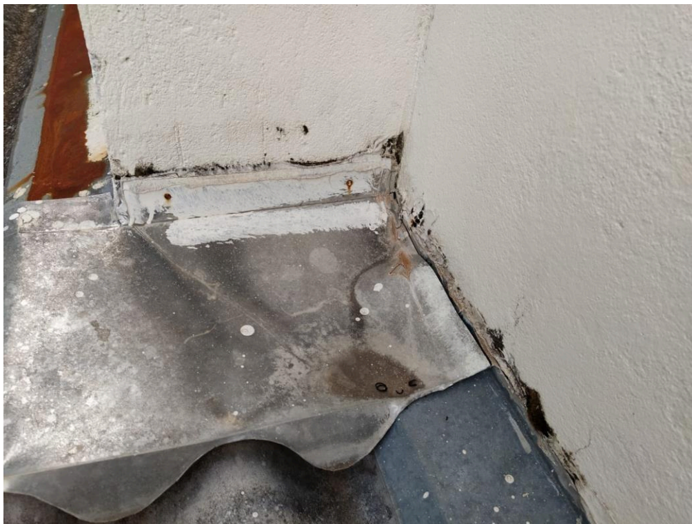
Fotografia 19 – Falta de vedação entre o rufo e a parede
