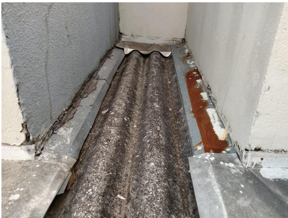
Fotografia 56 – Fissuras e falhas no reboco
