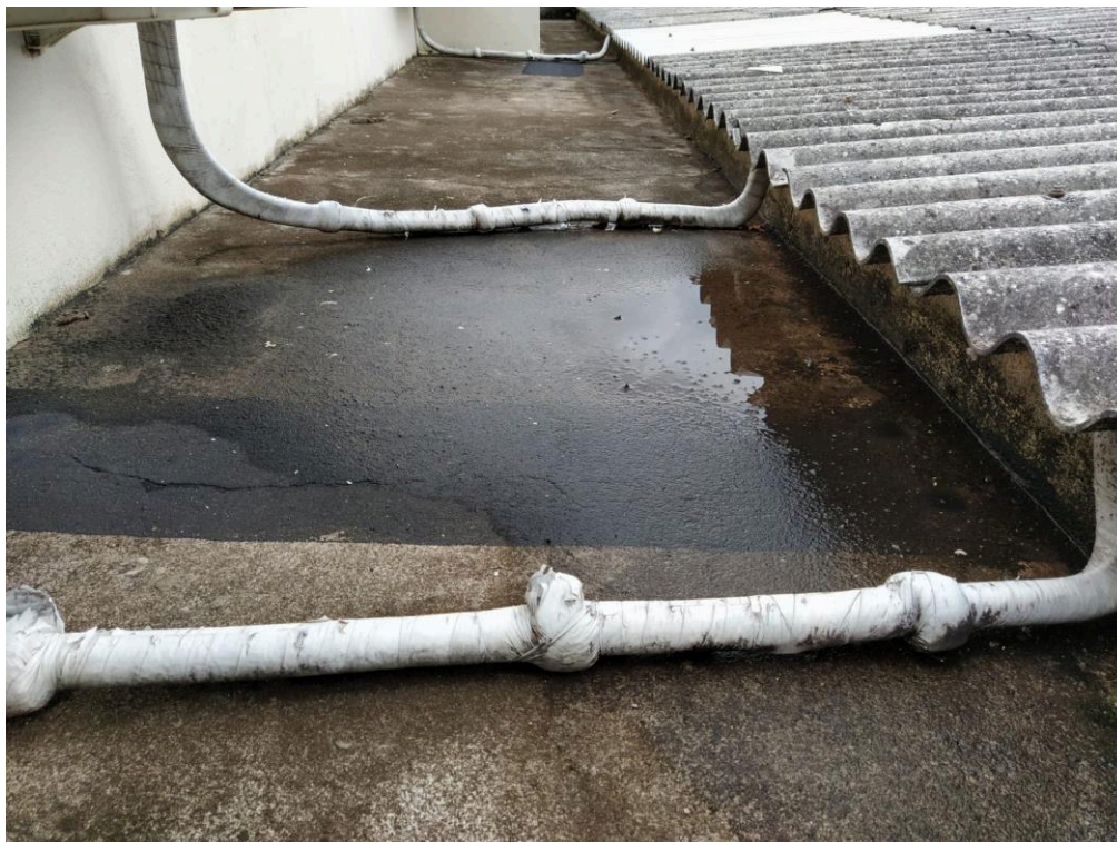
Fotografia 24 – Calha impermeabilizada com acúmulo de água
