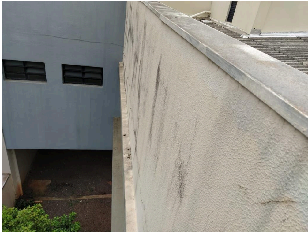
Fotografia 53 – Presença de fissuras na platibanda externa
