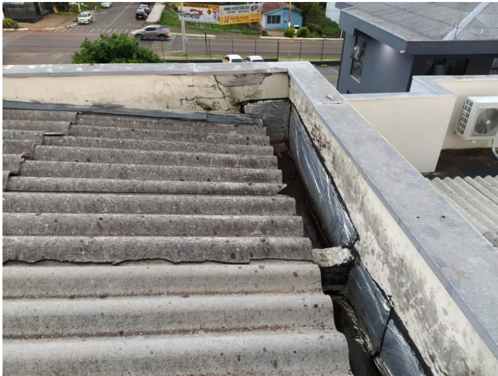
Fotografia 31 – Fissuração do reboco interno e vedação com manta asfáltica comprometida
