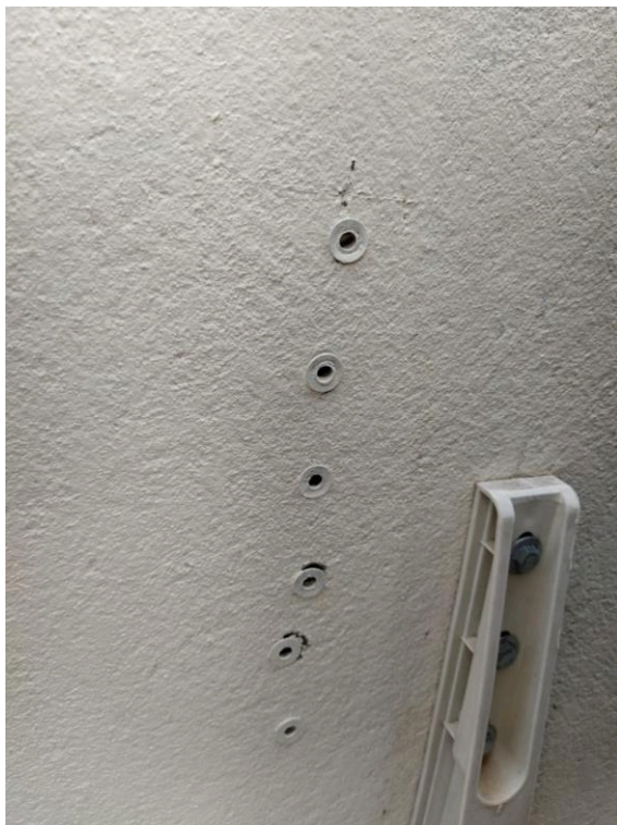
Fotografia 55 – Presença de furos sem vedação no sistema de climatização
