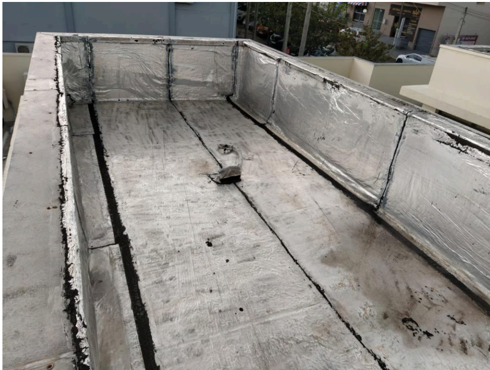
Fotografia 45 – Sistema de impermeabilização da claraboia 02 com descolamento
