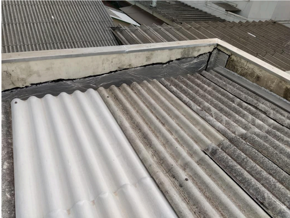
Fotografia 35 – Reparos paliativos feitos com manta aluminizada
