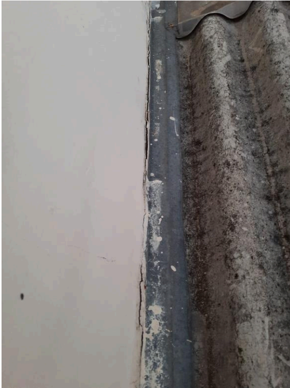
Fotografia 21 – Falta de vedação entre os rufos e a parede
