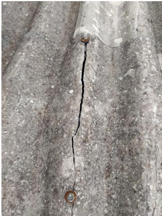
Fotografia 12 – Telhas de fibrocimento da cobertura com trincos
