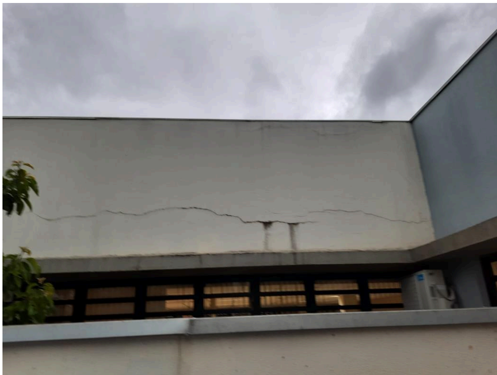
Fotografia 57 – Presença de fissuras na platibanda externa
