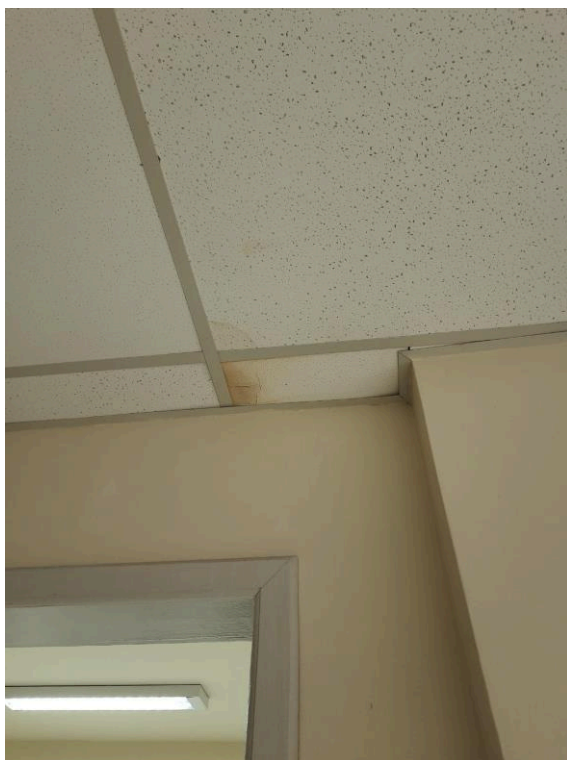
Fotografia 61 – Manchas de umidade no forro interno
