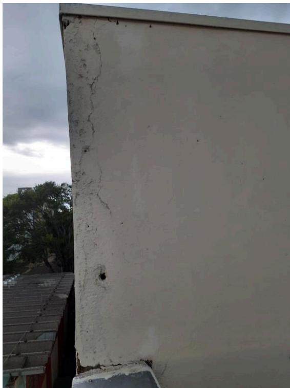
Fotografia 50 – Presença de furos sem vedação e fissuras
