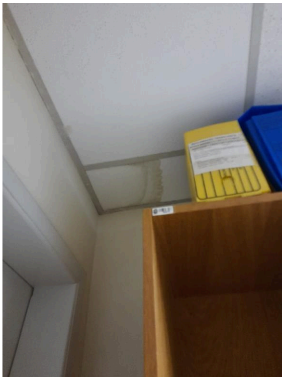
Fotografia 62 – Manchas de umidade no forro interno
