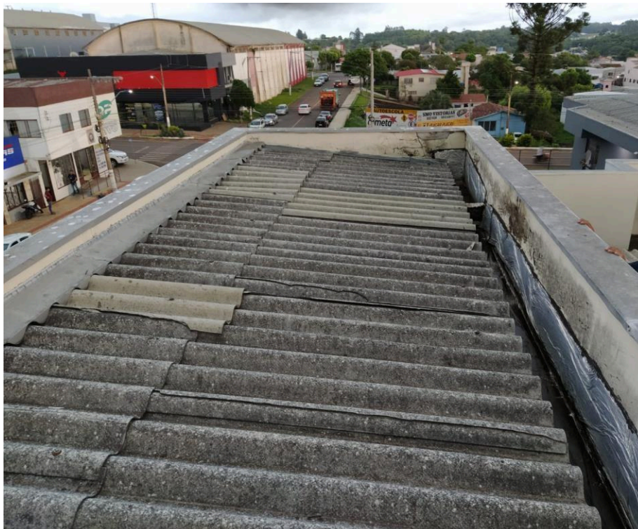
Fotografia 11 – Telhas de fibrocimento da cobertura com danos
