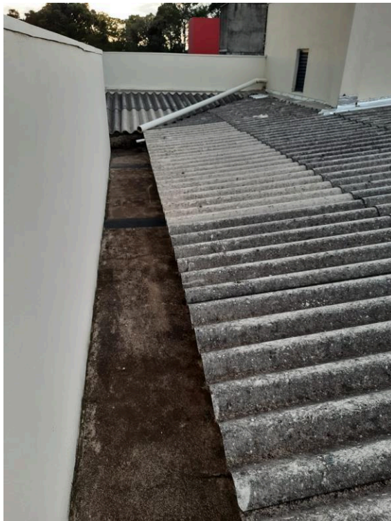
Fotografia 26 – Calha impermeabilizada com fissuras no contrapiso
