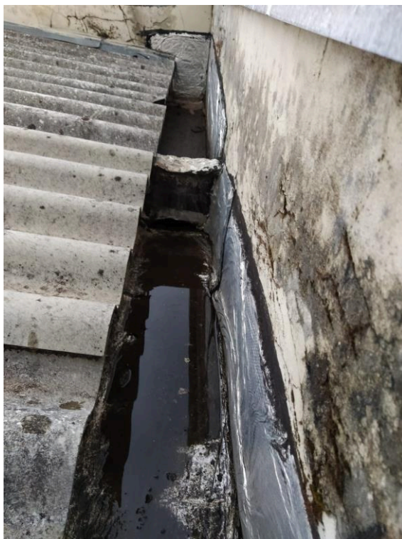
Fotografia 32 – Calha com acúmulo de água
