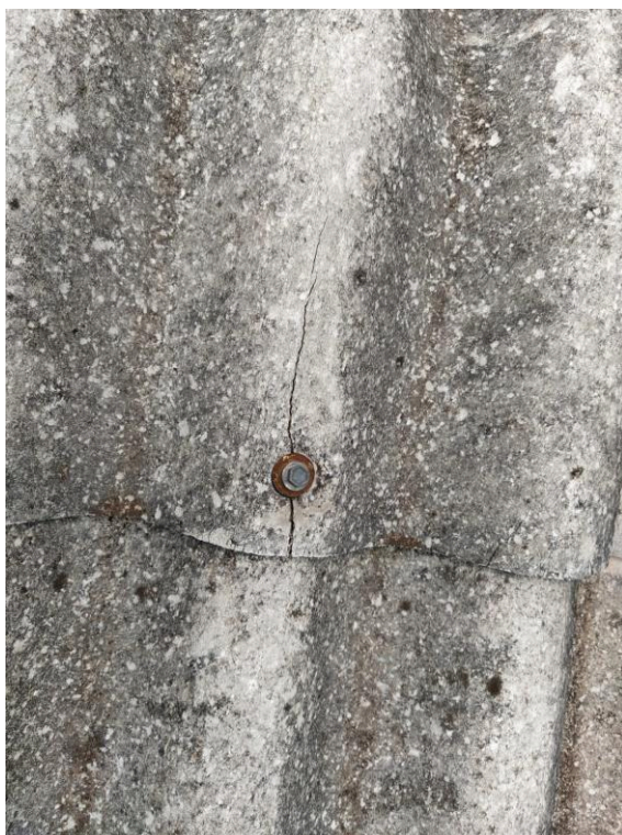
Fotografia 13 – Telhas de fibrocimento da cobertura com fissuras
