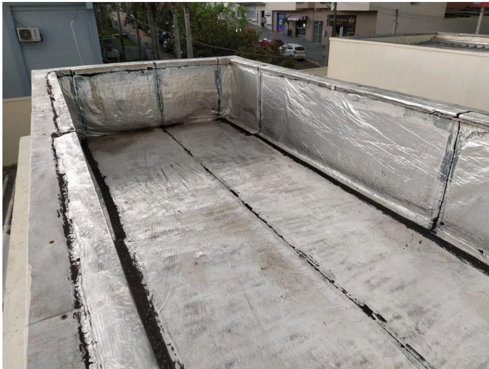
Fotografia 40 – Descolamento do sistema de impermeabilização da claraboia 01, formando bolsões nas paredes
