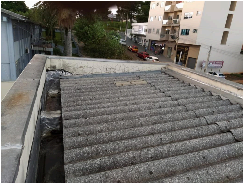
Fotografia 10 – Telhas de fibrocimento da cobertura com desgaste
