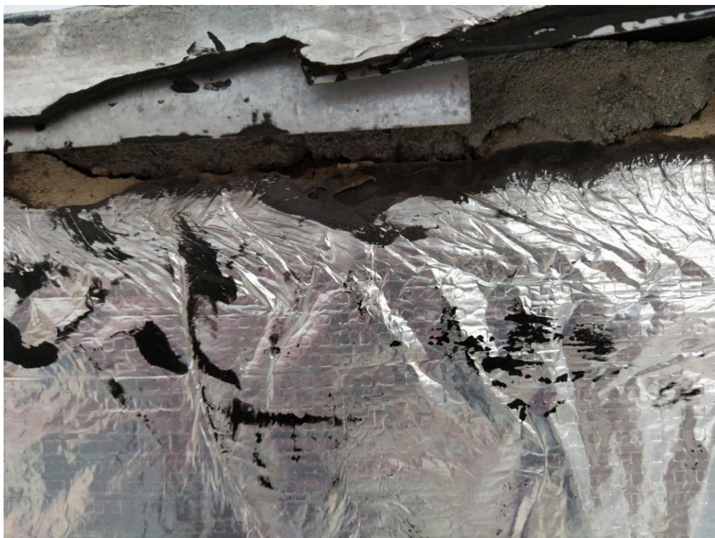
Fotografia 41 – Avaria do sistema de impermeabilização da claraboia 02
