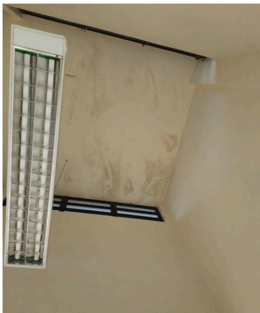
Fotografia 46 – Infiltrações na laje das clarabóias
