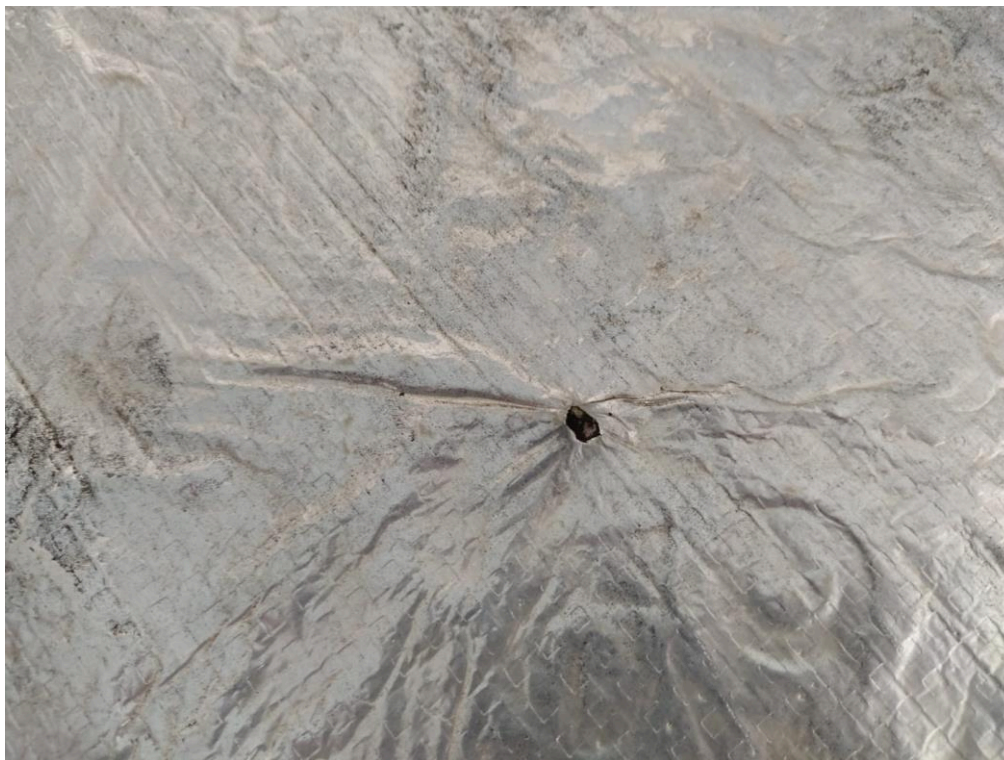
Fotografia 38 – Presença de furos no sistema de impermeabilização da claraboia 01
