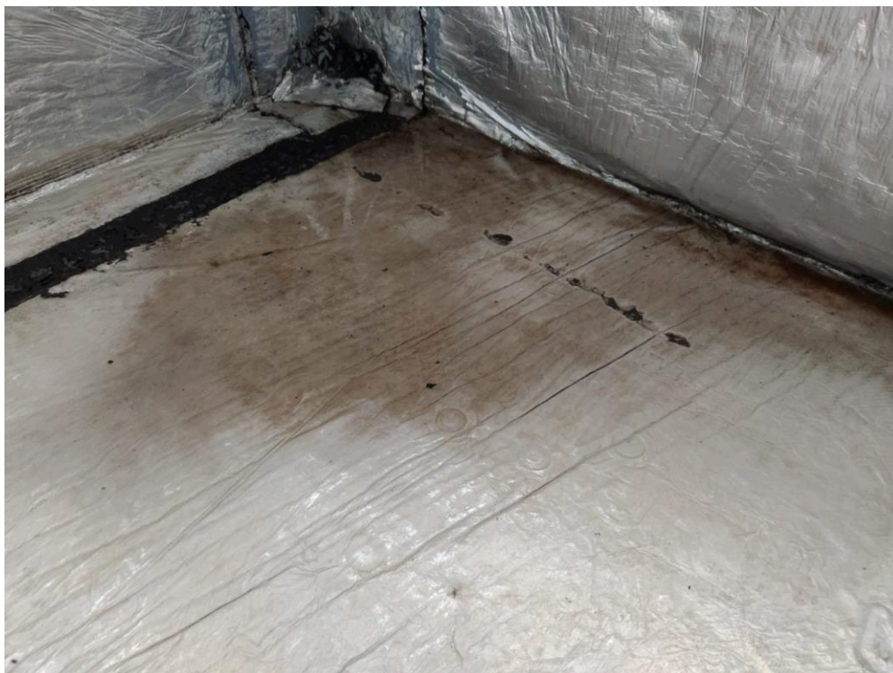
Fotografia 39 – Acúmulo de água no sistema de impermeabilização da claraboia 01
