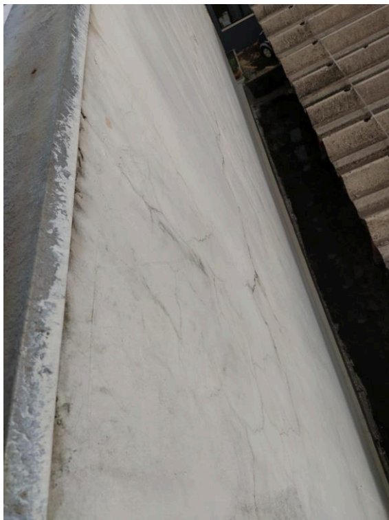
Fotografia 52 – Presença de fissuras na platibanda externa
