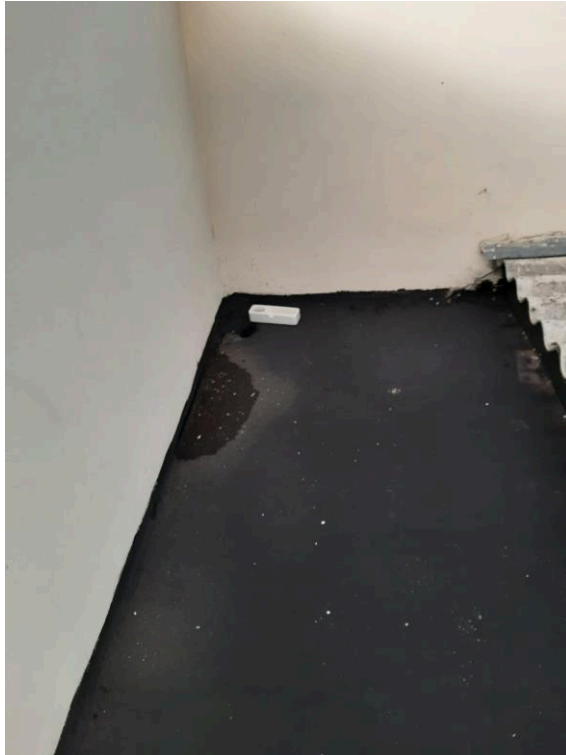
Fotografia 27 – Calha impermeabilizada com reparos paliativos
