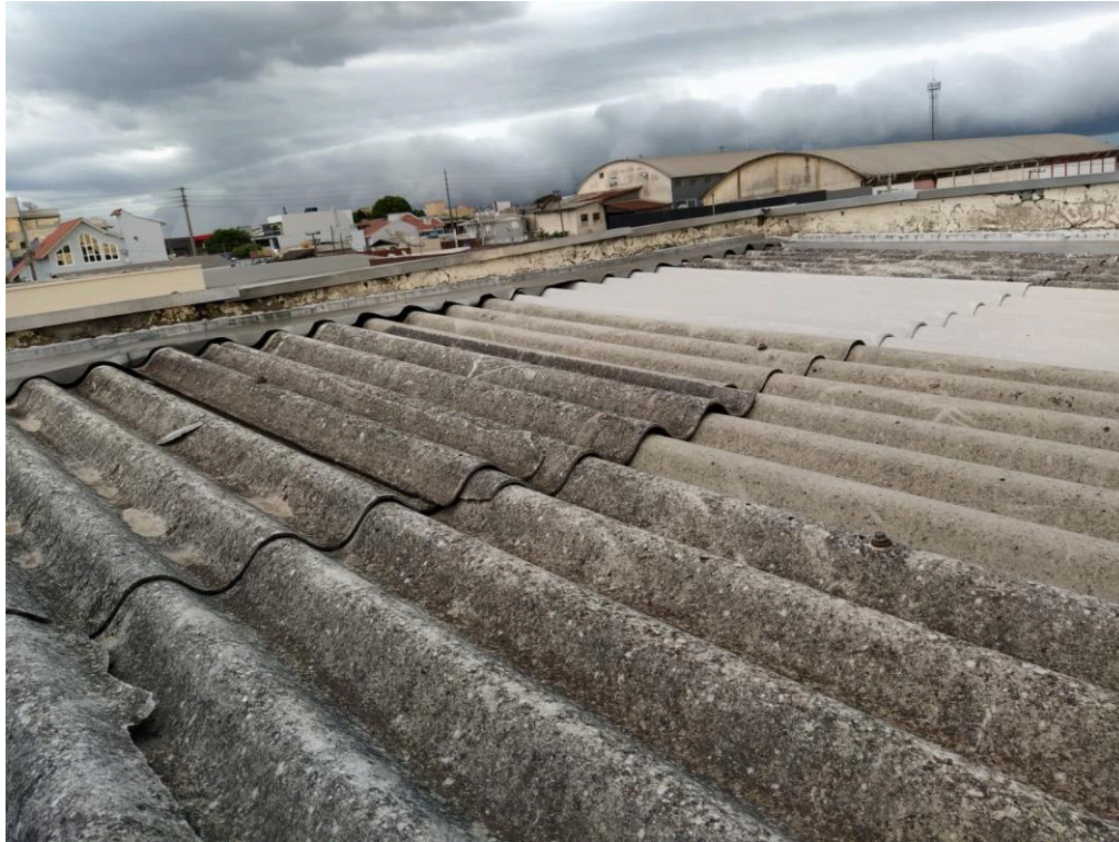
Fotografia 33 – Telhas com desgastes e danificadas
