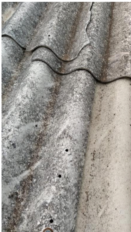
Fotografia 09 – Telhas de fibrocimento da cobertura com furos em diversos locais
