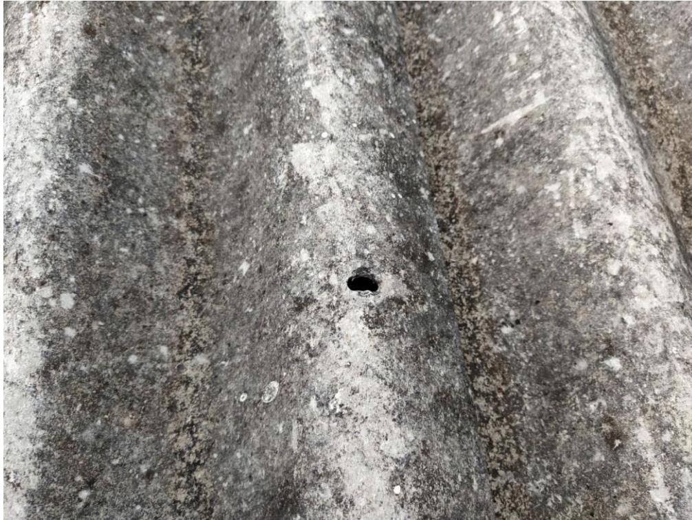
Fotografia 14 – Telhas de fibrocimento da cobertura com furos
