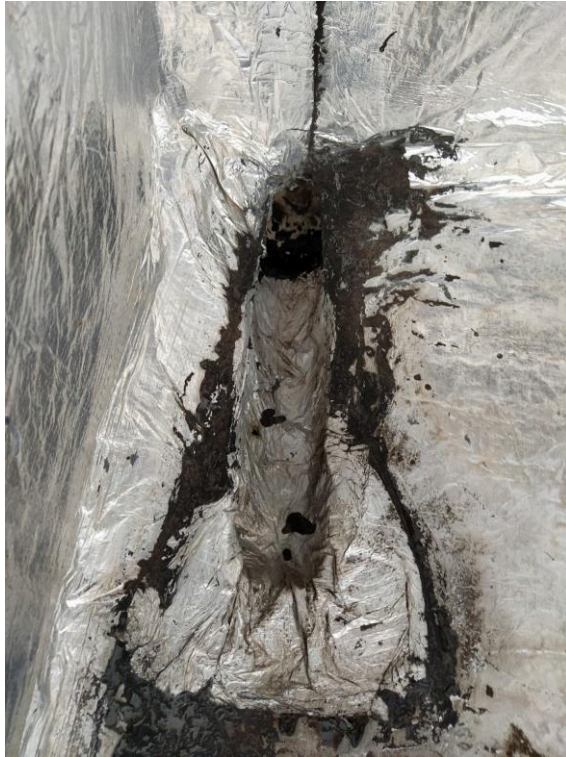
Fotografia 44 – Avaria na descida pluvial do sistema de impermeabilização da claraboia 02
