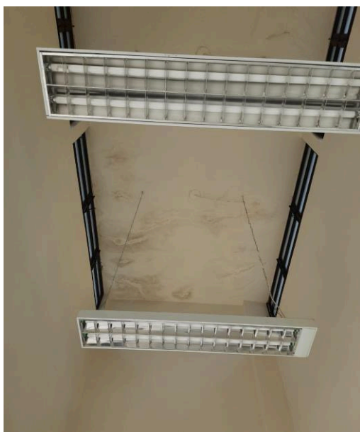
Fotografia 47 – Infiltrações na laje das clarabóias
