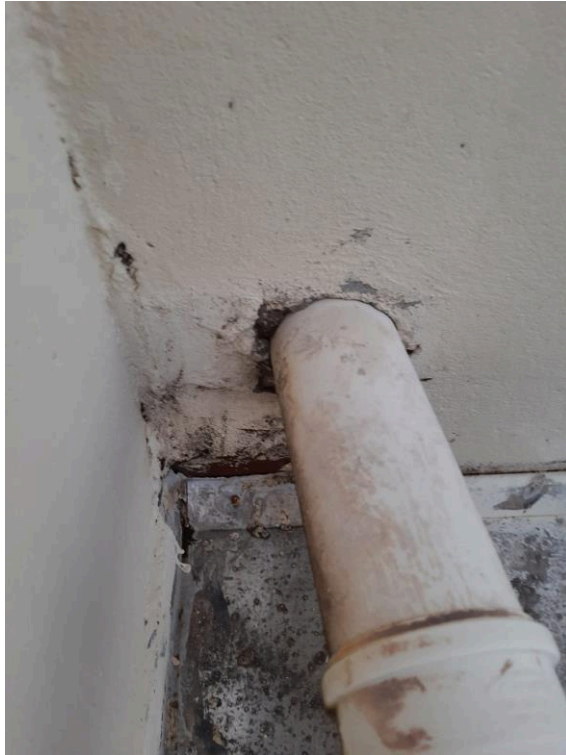
Fotografia 51 – Tubulação sem vedação adequada
