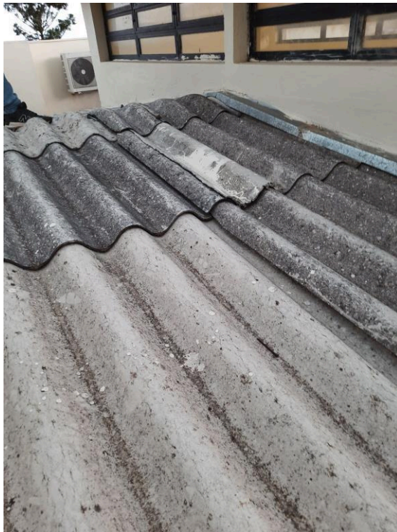
Fotografia 08 – Telhas de fibrocimento da cobertura soltas
