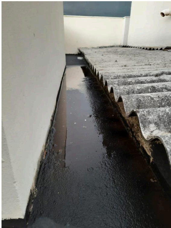
Fotografia 23 – Calha impermeabilizada com acúmulo de água
