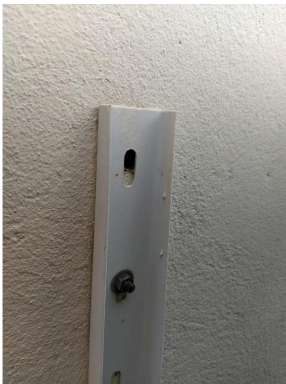
Fotografia 54 – Presença de furos sem vedação no sistema de climatização
