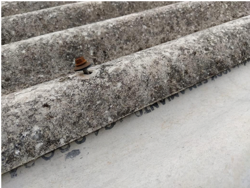
Fotografia 15 – Telhas de fibrocimento da cobertura sem vedação dos parafusos
