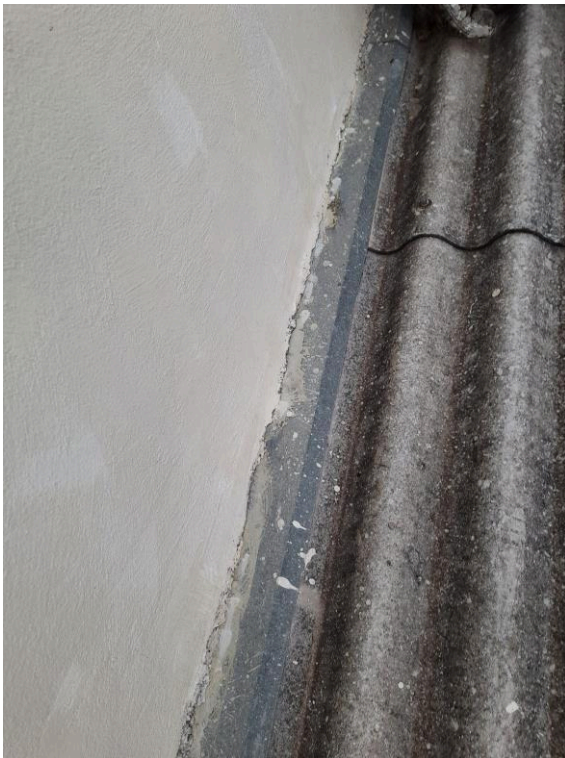
Fotografia 22 – Falta de vedação entre os rufos e a parede
