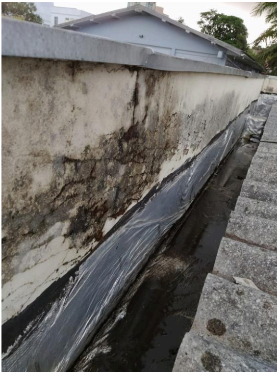
Fotografia 30 – Fissuração do reboco interno
