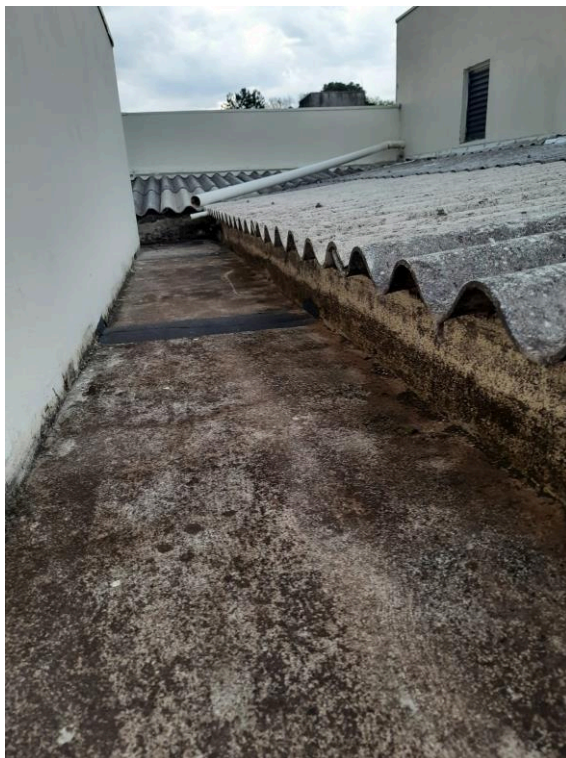
Fotografia 28 – Calha impermeabilizada com reparos paliativos e presença de fissuras
