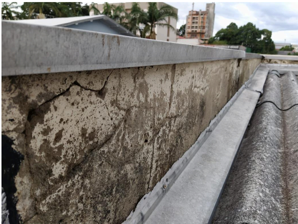
Fotografia 34 – Fissuração do reboco interno e falta de vedação entre a parede e o rufo
