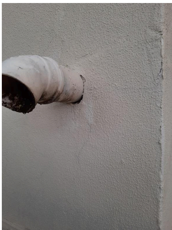
Fotografia 48 – Tubulação sem vedação adequada
