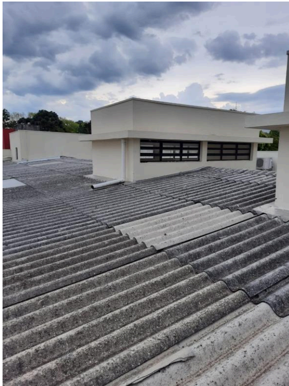
Fotografia 05 – Telhas de Fibrocimento da Cobertura
