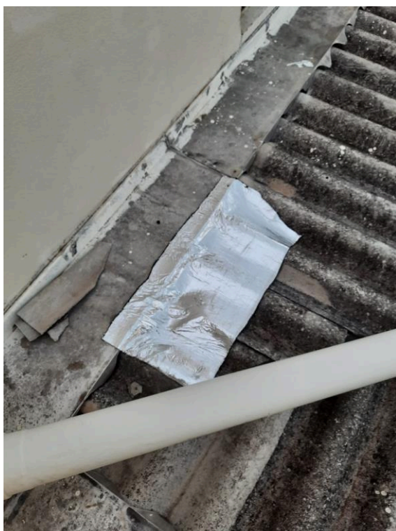
Fotografia 07 – Telhas de fibrocimento da cobertura com reparos paliativos
