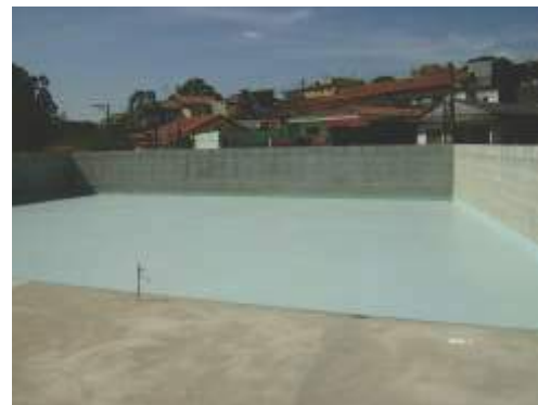
Aplicação do Hidroplast sobre o primer
