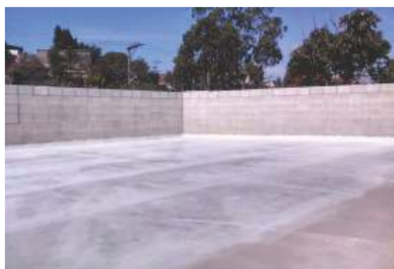
Aplicação do primer simultaneamente com a tela
