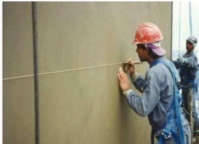
Executar nivelamento e marcação para o corte duplo (largura 15mm)
