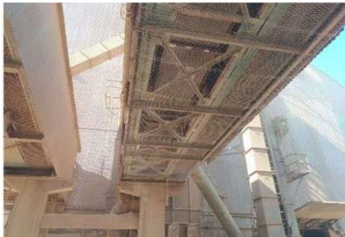
**Imagem 18** - Telas de proteção em metal instaladas.
