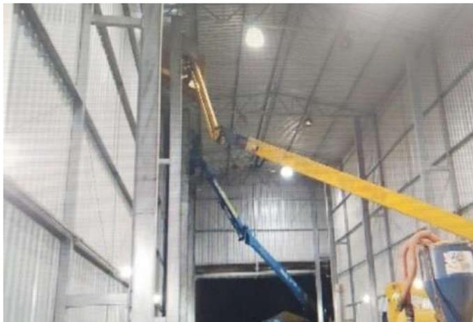
**Imagem 17** - Telas de proteção em nylon instaladas.
