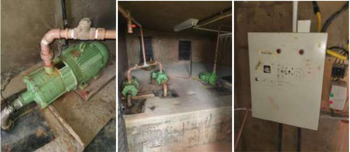
10. Motobomba marca Brasil/Jacuzzi, modelo 2DM1-T/ferro fundido, potência 2cv, mono 220v, com quadro elétrico de acionamento e comando.
