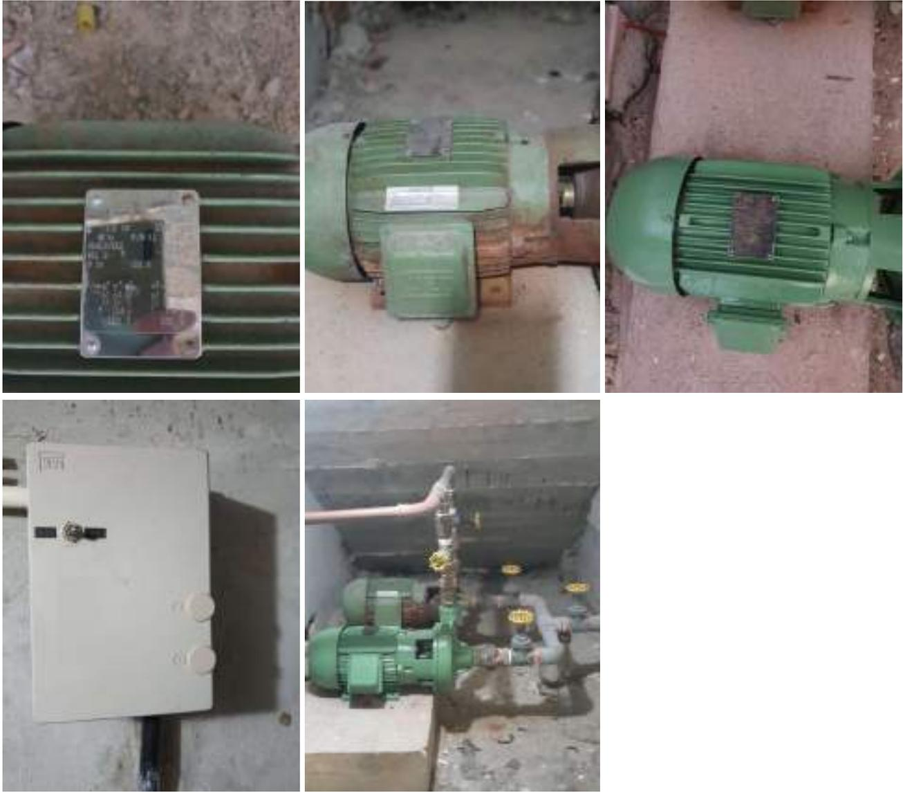
13. Motobomba de recalque, marca Schneider ME-AL 1315, potência 1,5cv, trifásico 220/380, 60H, com quadro elétrico de acionamento e comando.
