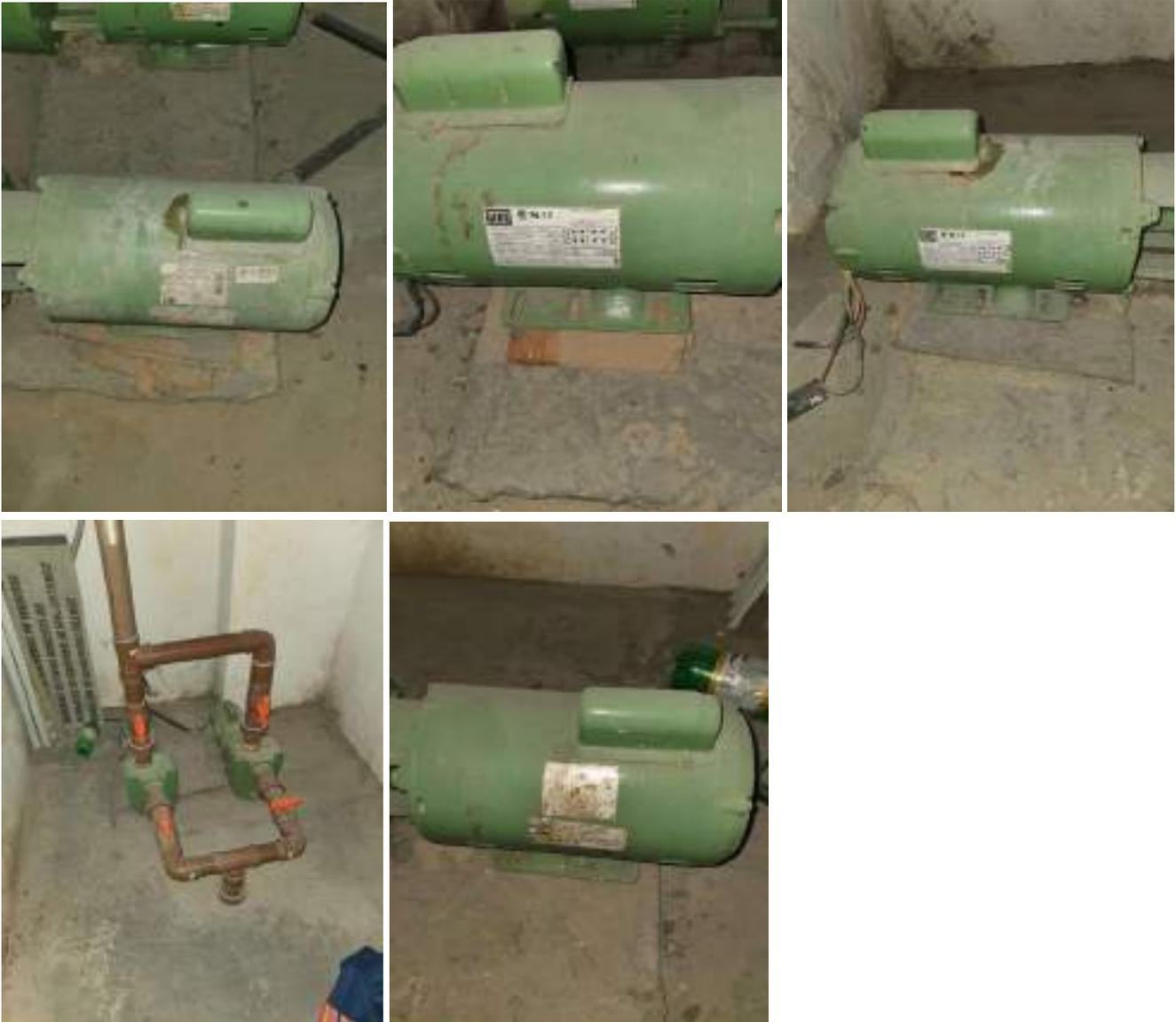
12. Motobomba, marca Schneider/WEG, modelo centrífuga/ferro fundido BC-20R, Potência 5cv, Trifásico 220/380v, com quadro elétrico de acionamento e comando.
