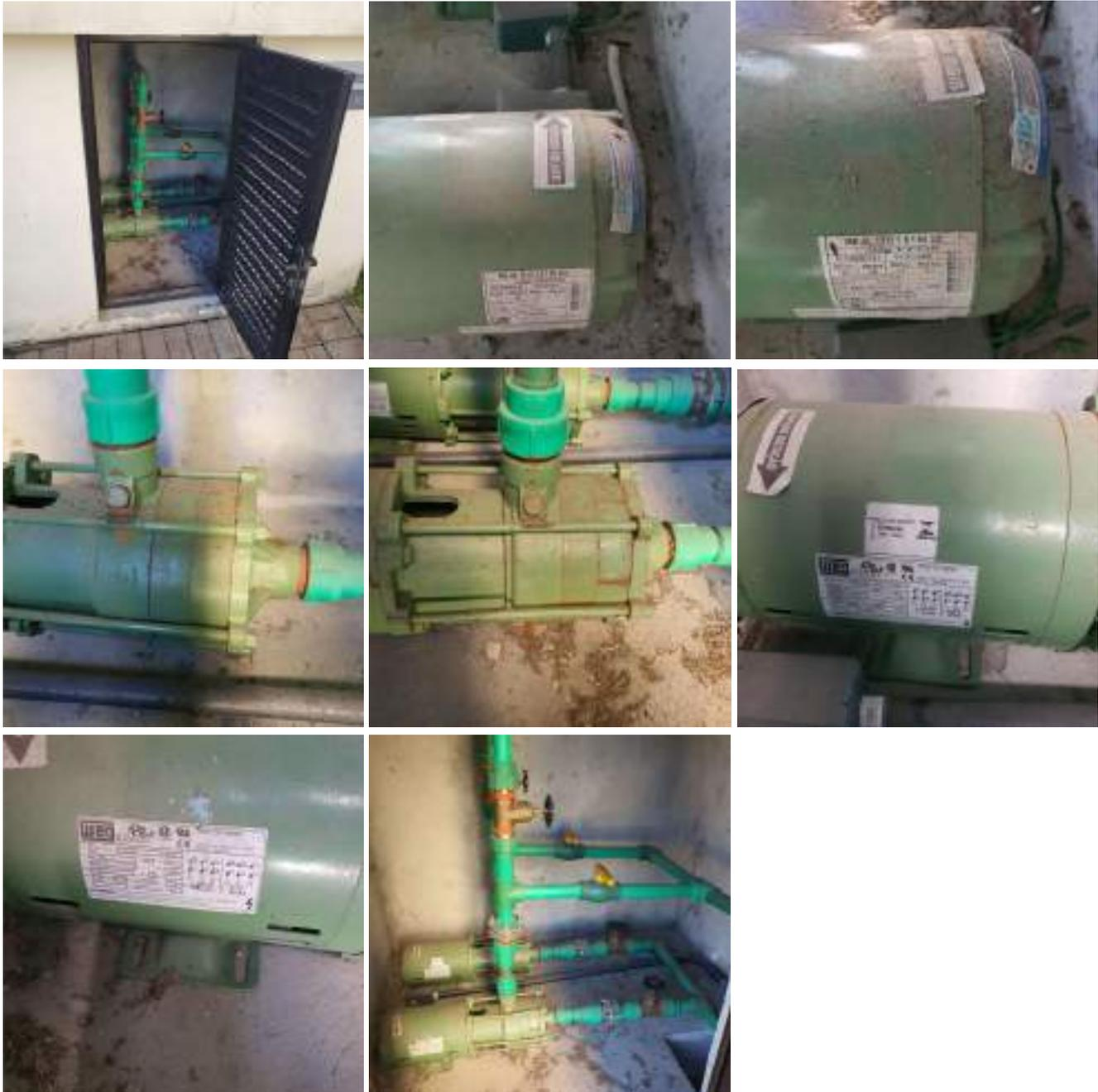
14. Motobomba Jockey, marca KSB, modelo P-1000, potência 1 cv, 220v, com quadro elétrico de automação para acionamento e comando com painel LCD, marca Albuquerque G3MR (quadro elétrico referente aos itens 14, 15 e 16).
