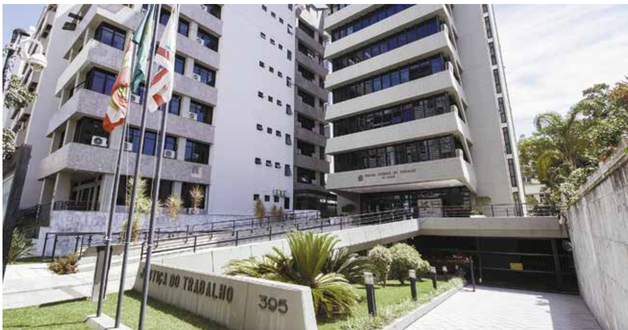
Prédio da sede administrativa e seus anexos foram adaptados para acomodar área judiciária, que estava em imóvel alugado
