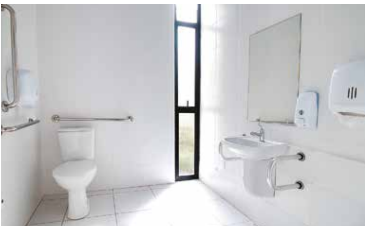
Os banheiros de uso público foram reformados e adaptados para acessibilidade
