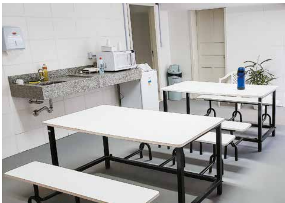
Refeitório ganhou cuba e bancada em granito, além de rede elétrica para instalação de aparelho microondas, frigobar e bebedouro
