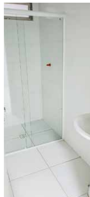
Nos banheiros, houve substituição de azulejos, pisos e portas
