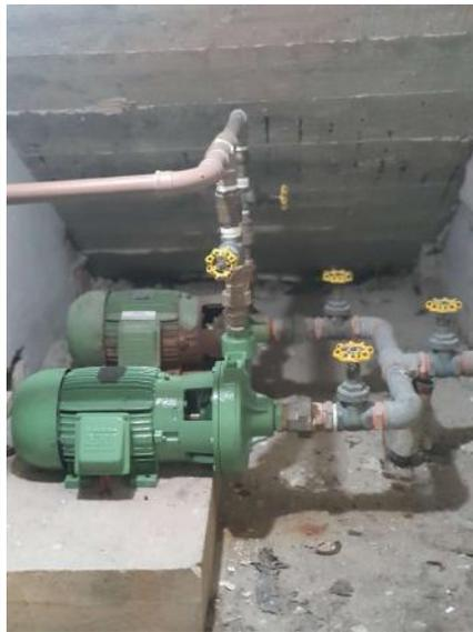
13. Motobomba de recalque, marca Schneider ME-AL 1315, potência 1,5cv, trifásico 220/380, 60H, com quadro elétrico de acionamento e comando.
