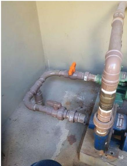
11. Motobomba, marca Schneider/WEG, modelo auto aspirante/ferro fundido BCA - 22 M60 1/2, Potência 2cv, mono 220v, com quadro elétrico de acionamento e comando.
