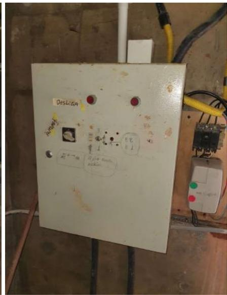
10. Motobomba marca Brasil/Jacuzzi, modelo 2DM1-T/ferro fundido, potência 2cv, mono 220v, com quadro elétrico de acionamento e comando.
