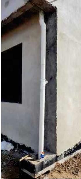
Descida pluvial com dreno ar condicionado
