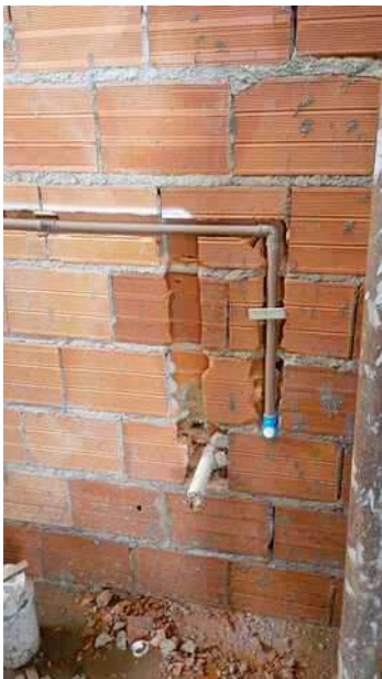
Sanitário Masc ponto da pia
