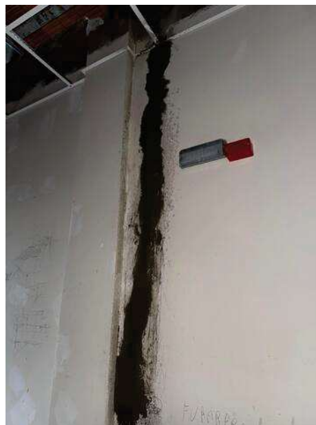
Fechamento de vãos
