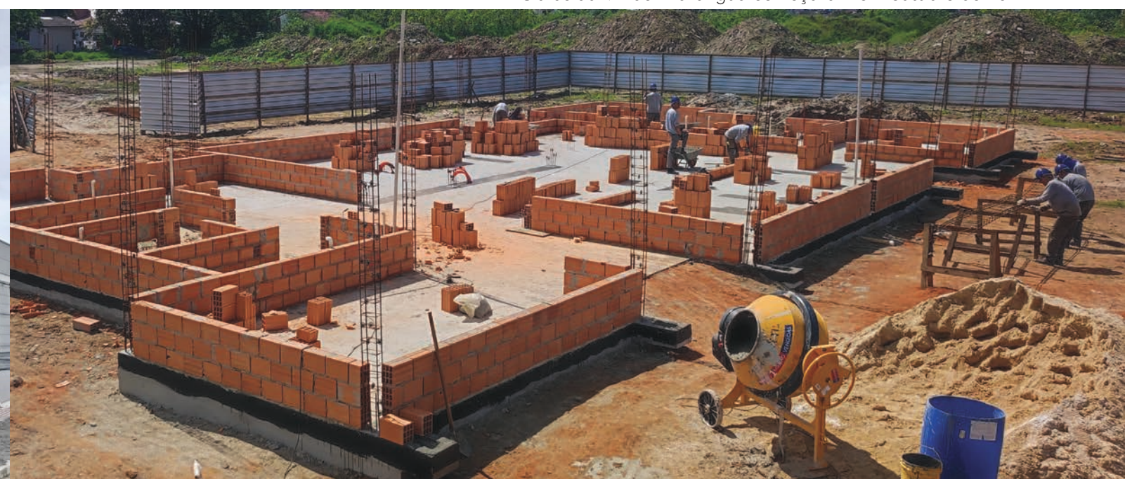
Obras da VT de Araranguá começaram em outubro de 2024
